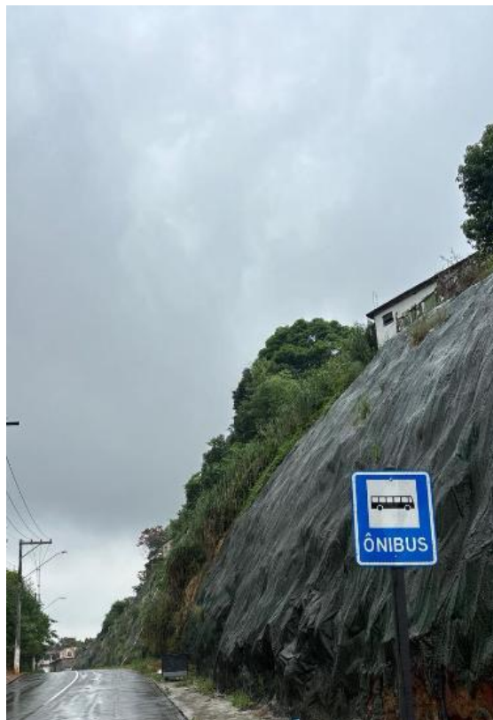
Imagem 05: Foto atualizada do local da obra.
