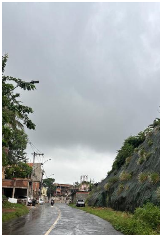
Imagem 07: Foto atualizada do local da obra.
