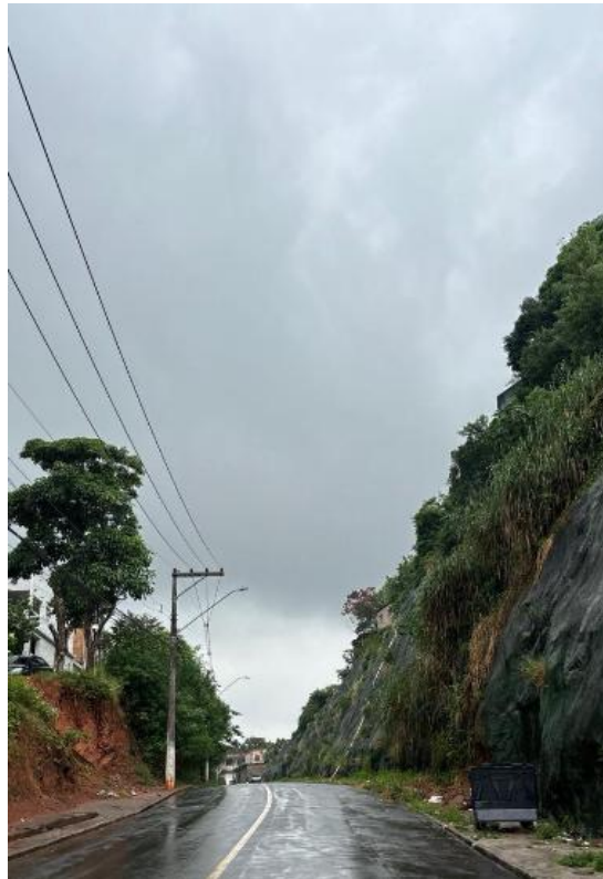
Imagem 04: Foto atualizada do local da obra.
