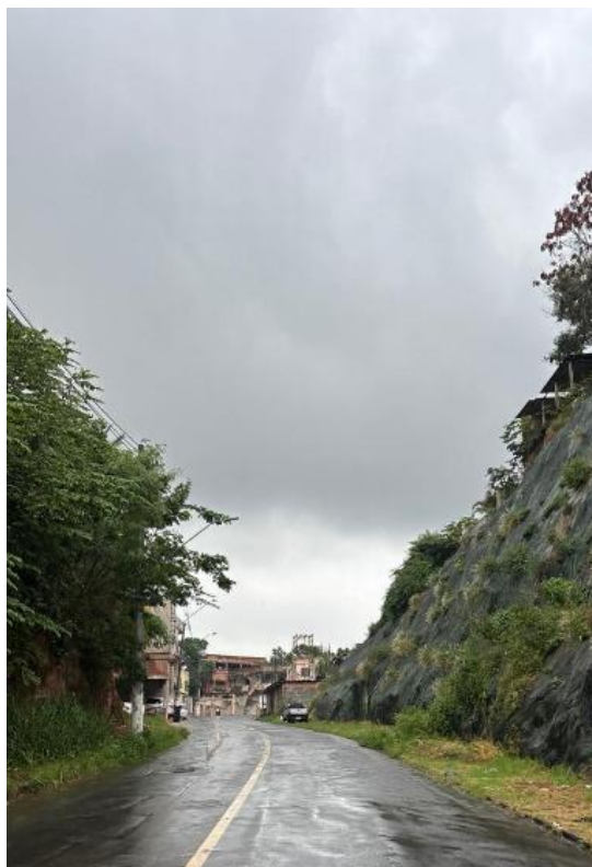
Imagem 06: Foto atualizada do local da obra.
