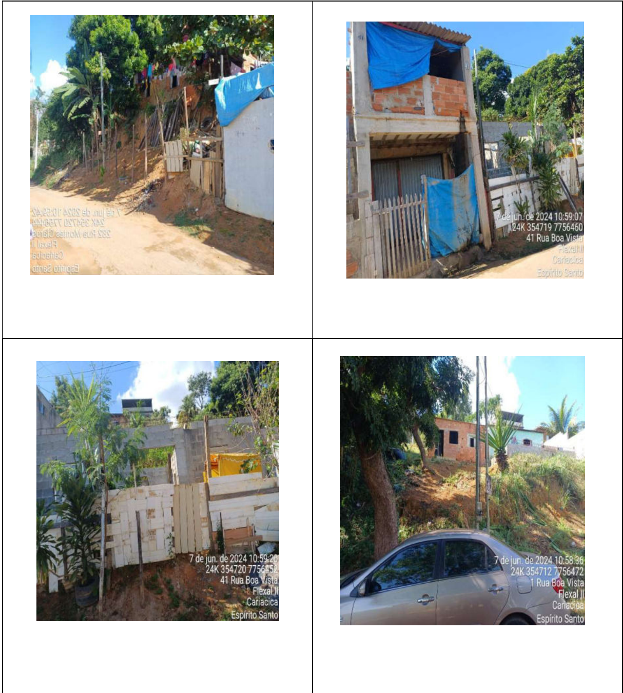
Imagens da contenção do SETOR 12 realizadas no dia 07/06/2024
