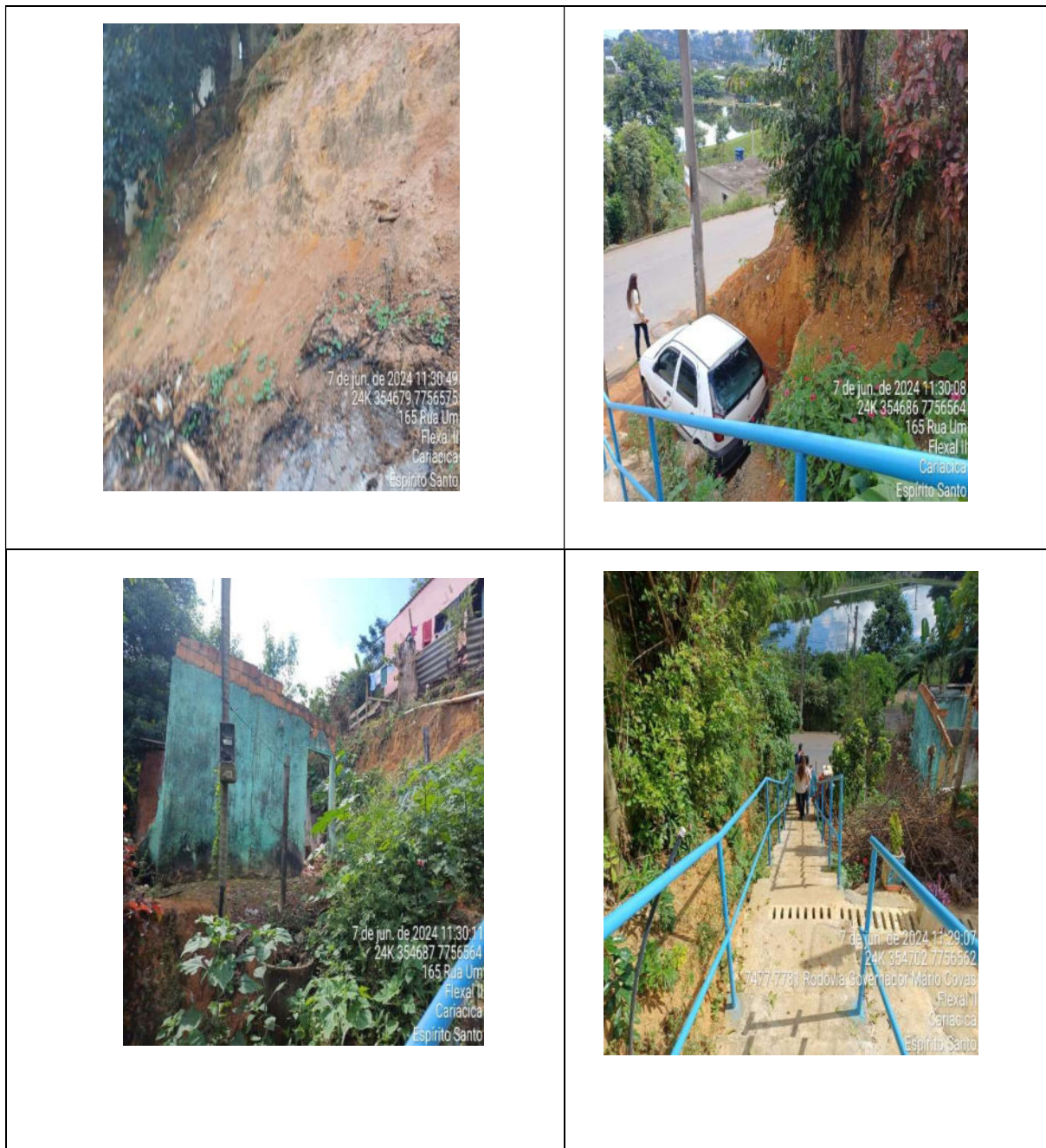
Imagens da contenção do SETOR 16 realizadas no dia 07/06/2024
