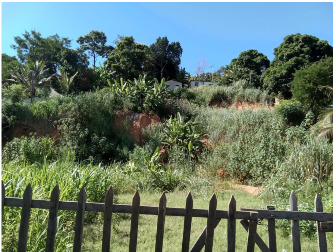
Figura 38 - Vista parcial da encosta escavada existente no setor.
