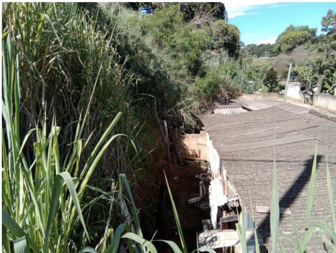
Figura 35 - Vista parcial da encosta escavada existente no setor.
