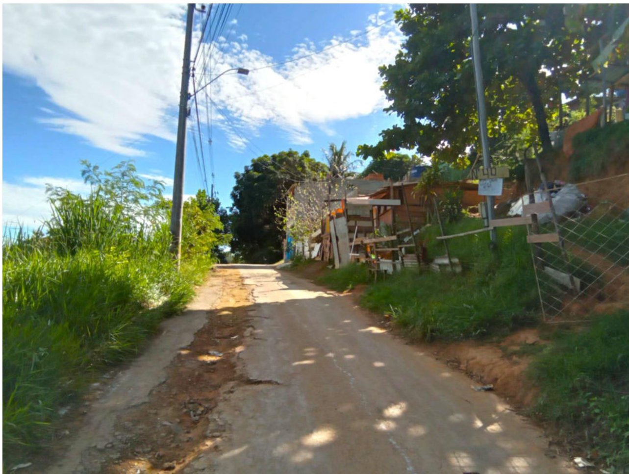
Figura 24 – Vista parcial das edificações do setor. Detalhamento de infraestrutura de pavimento deficiente, facilitando a infiltração de água pluvial no solo e possível linha de ruptura, em possível evento extremo.
