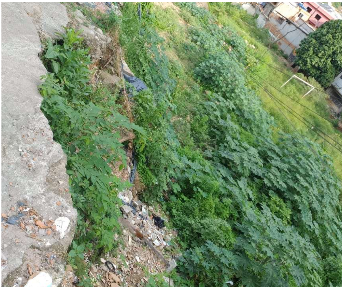
Foto 03 – Local de ocorrência do desmoronamento da via.
