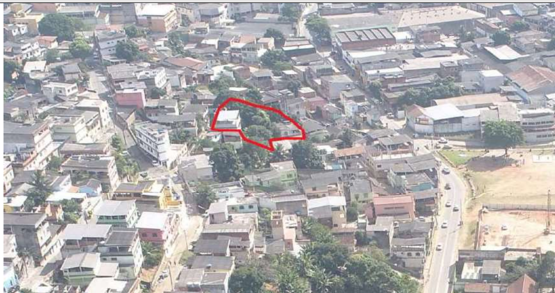
Foto 1- Delimitação do setor de risco tendo como referência a Rua Resplendor como limite superior seguindo até o entroncamento com a Rua Leopoldina.
