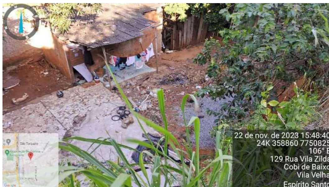
Foto 3 - Mesmo cenário da foto anterior, a partir da montante do talude.
