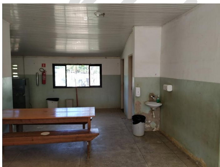
Vista parcial do refeitório
