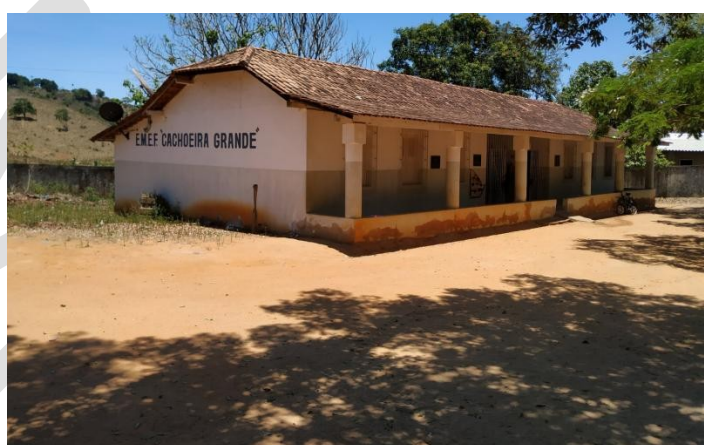
Vista parcial do prédio escolar
