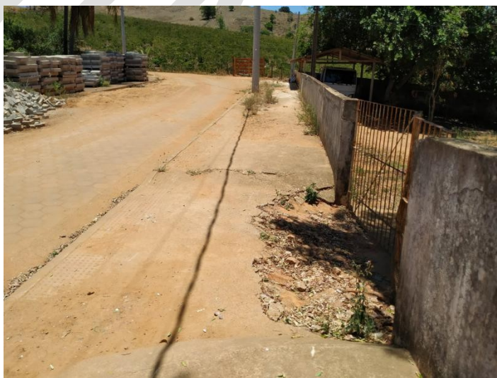
Vista parcial da calçada
