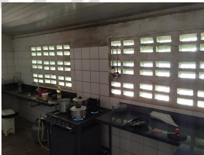
Vista parcial da cozinha
