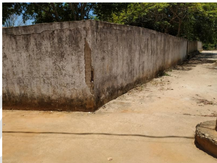
Vista parcial do muro
