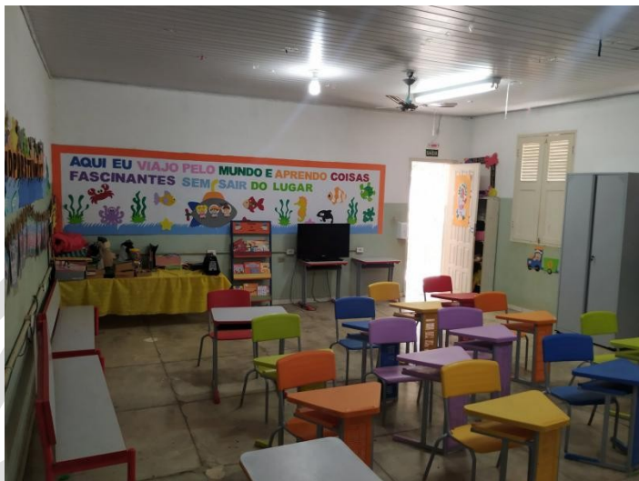
Vista parcial sala de aula
