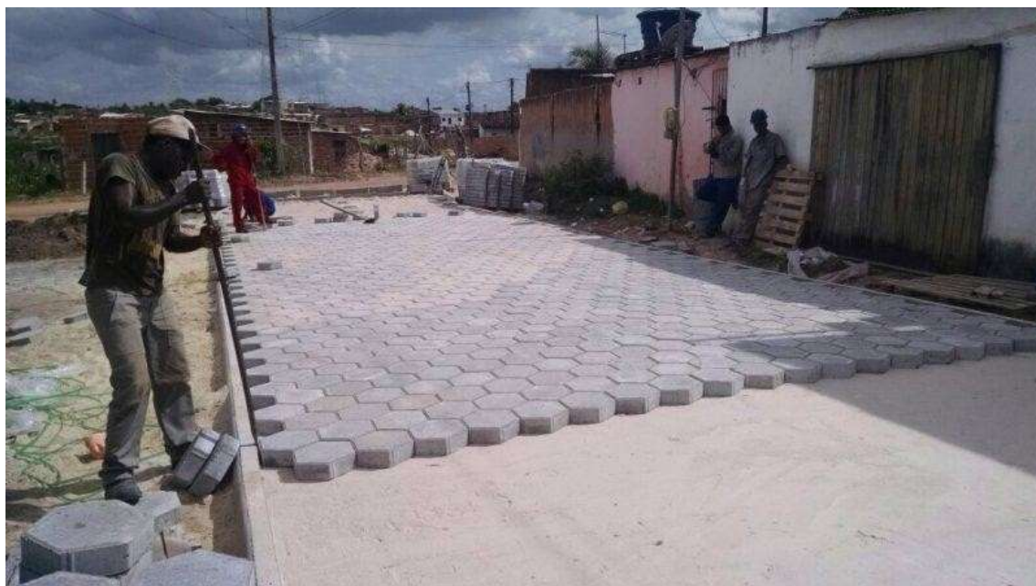
Figura 6.4 – Assentamento dos Blocos na Prática
