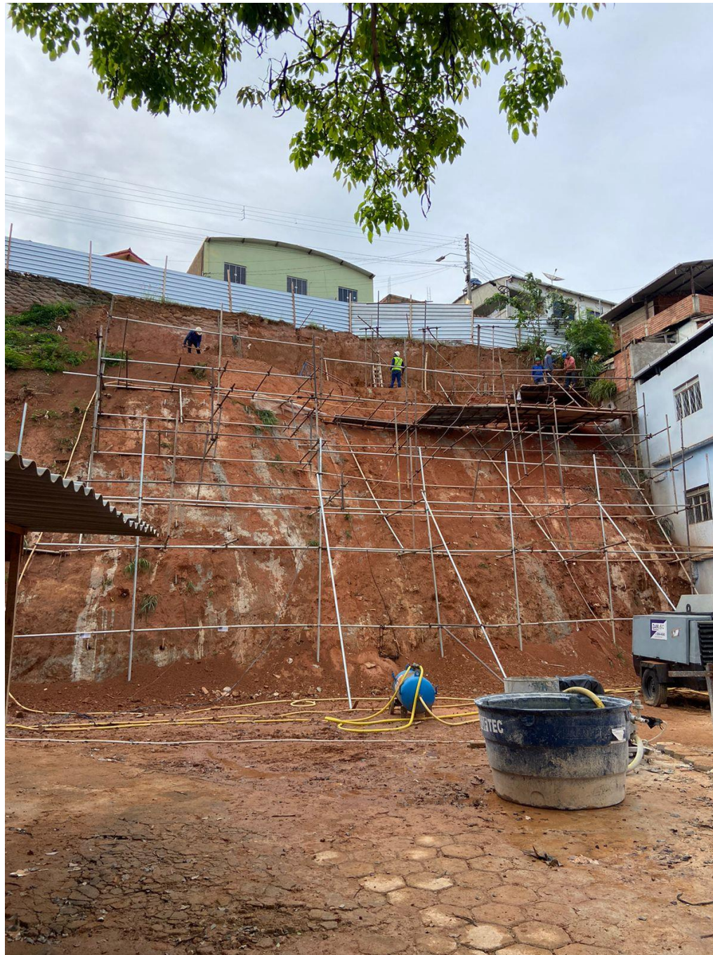
Andaimes tubulares utilizados para execução de solo grampeado pela empresa
