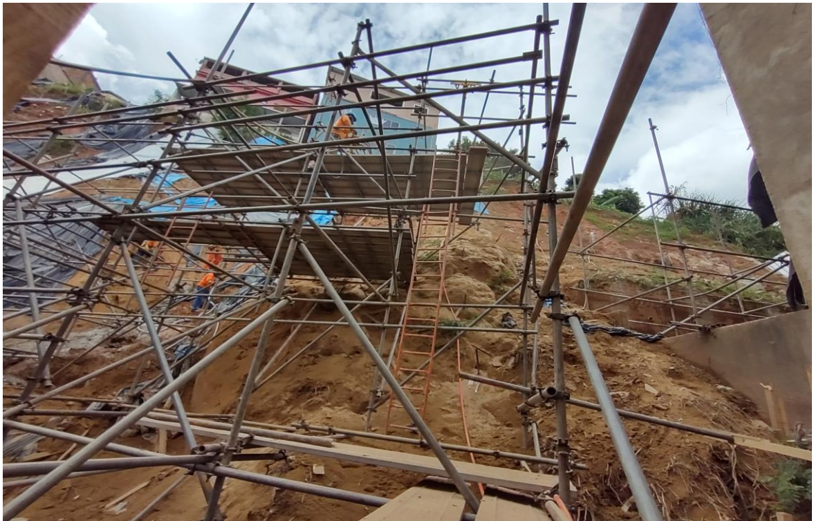
Andaimes tubulares utilizados para execução de solo grampeado pela empresa
