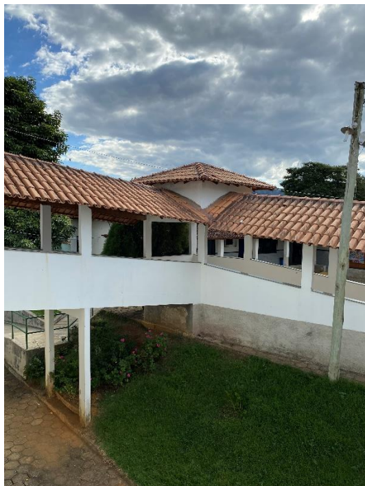
Figura 02 – Rampa de Acesso 2º Pav. Bloco 02. Serpenge ,2023
