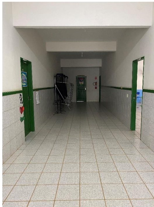
Figura 15 – Piso da circulação. Serpenge ,2023
