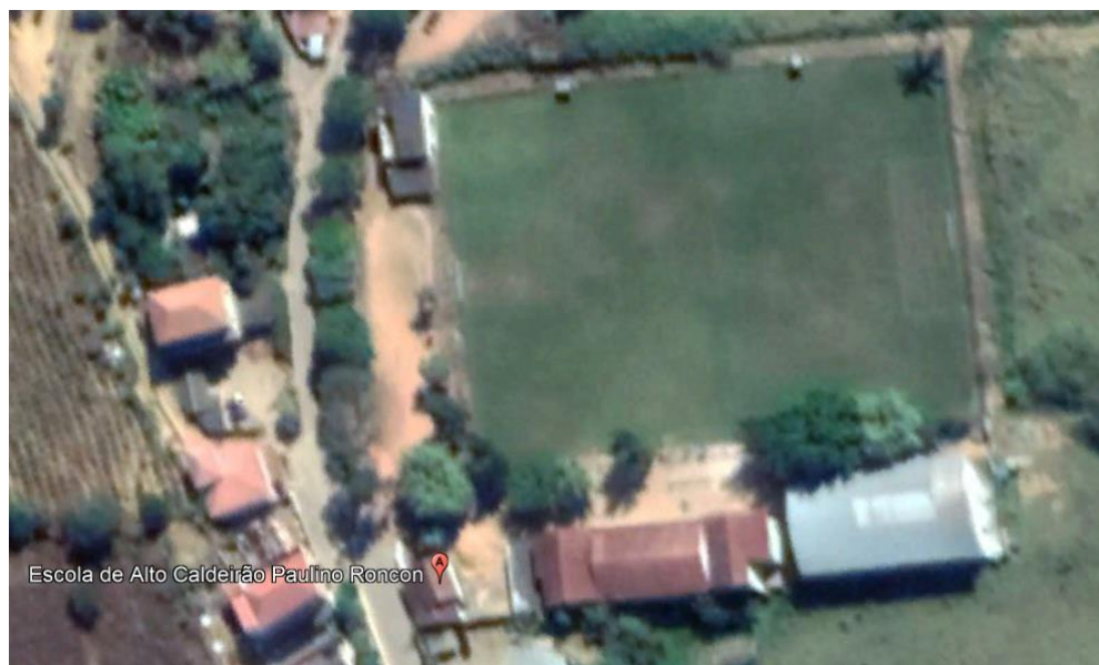
Figura 4 – Vista vertical das estruturas analisadas.
