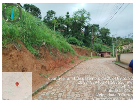
FOTO N.º 16/27 – Muro de contenção Via Principal Conceição do Muqui.
