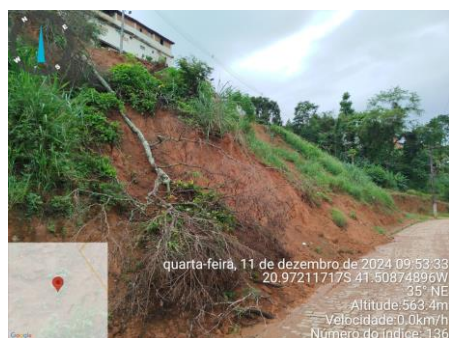
FOTO N.º 22/27 – Muro de contenção Via Principal Conceição do Muqui.
