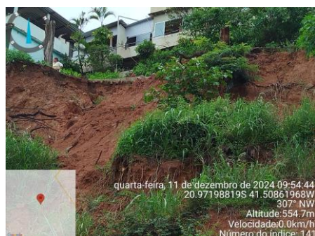
FOTO N.º 19/27 – Muro de contenção Via Principal Conceição do Muqui.
