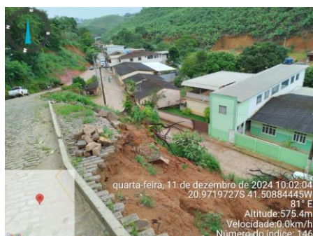
FOTO N.º 20/27 – Muro de contenção Via Principal Conceição do Muqui.
