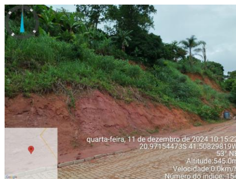
FOTO N.º 15/27 – Muro de contenção Via Principal Conceição do Muqui.
