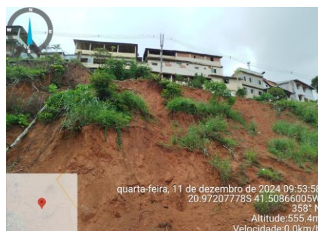
FOTO N.º 21/27 – Muro de contenção Via Principal Conceição do Muqui.
