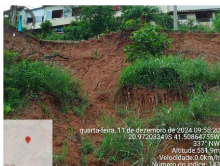
FOTO N.º 17/27 – Muro de contenção Via Principal Conceição do Muqui.
