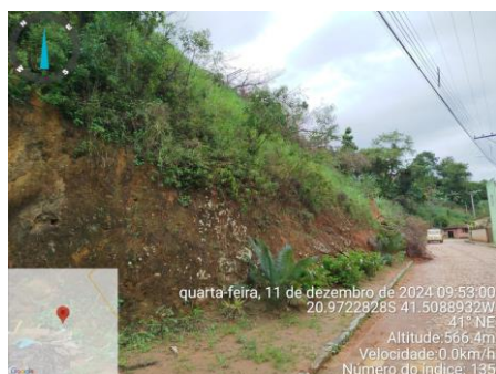
FOTO N.º 23/27 – Muro de contenção Via Principal Conceição do Muqui.
