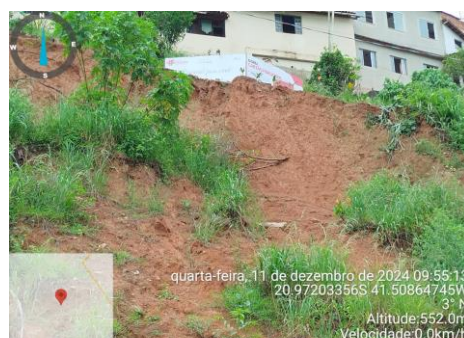
FOTO N.º 18/27 – Muro de contenção Via Principal Conceição do Muqui.
