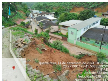
FOTO N.º 14/27 – Muro de contenção Via Principal Conceição do Muqui.
