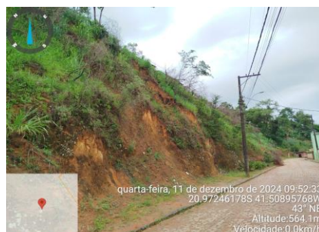
FOTO N.º 24/27 – Muro de contenção Via Principal Conceição do Muqui.
