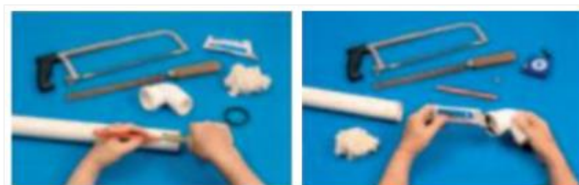
Figura 47 - Acomodação anel de borracha
