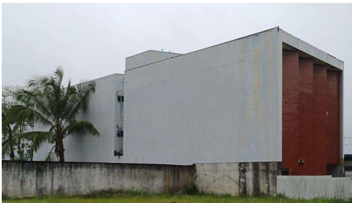
Figura 1 – Edificação situada à Rua Presidente Castelo Branco
