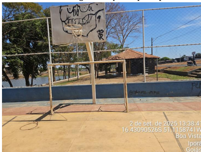
Foto 01 – Vista geral da quadra poliesportiva
