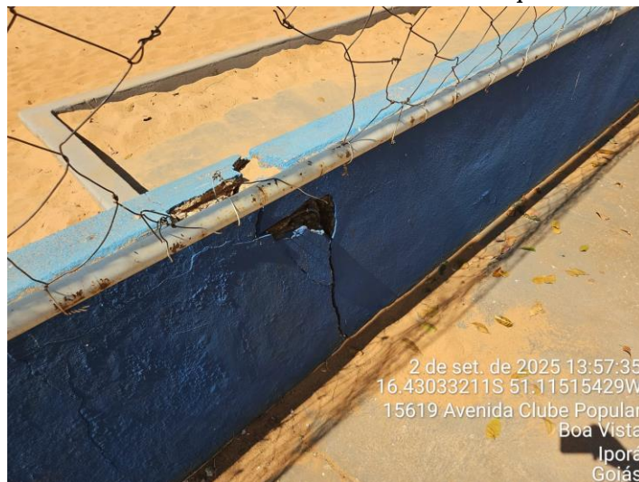
Foto 05 – Detalhe do cercamento e entorno da quadra de areia
