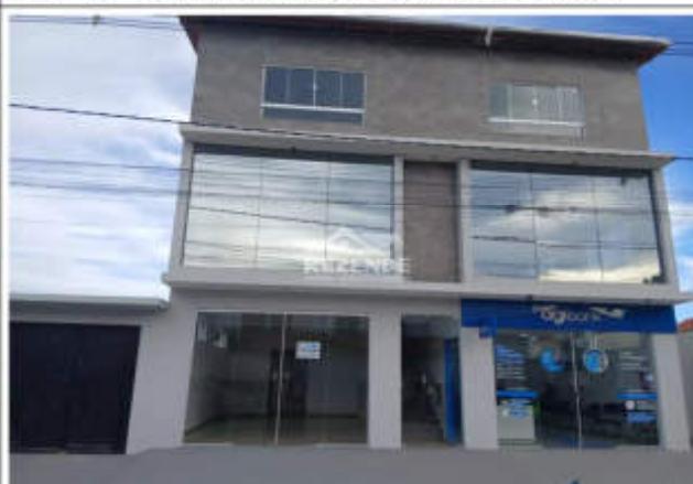
Foto 12 - Rua Barão do Rio Branco, 26 – Térreo B, Centro
