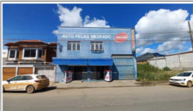
Foto 01 - Avenida Olindo de Miranda, 1178, Centro
