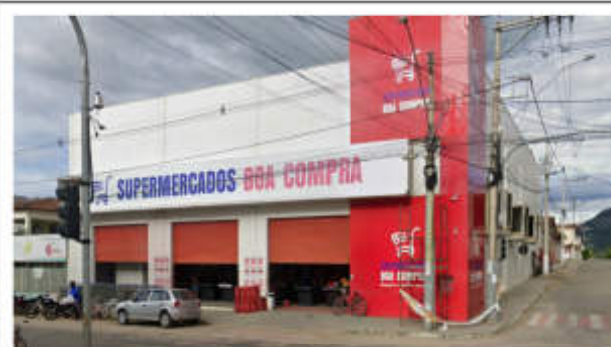
Foto 04 - Avenida Olindo de Miranda, 864, Centro
