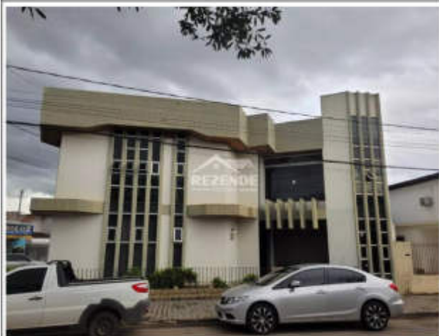
Foto 05 - Avenida Olindo de Miranda, 260, Centro
