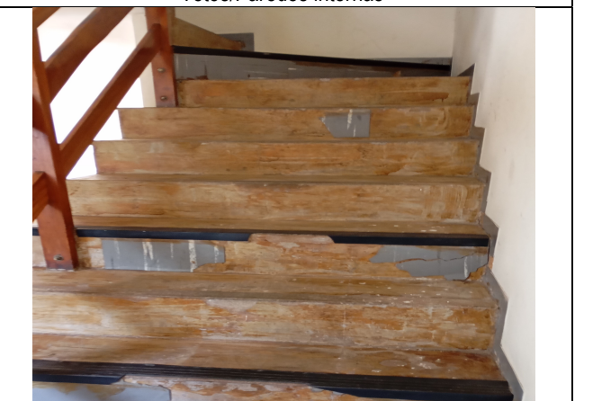
Escada sem revestimento
