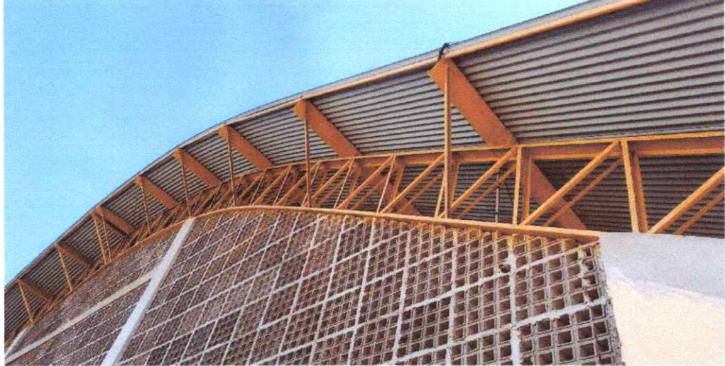
Figura 7 – A construção de alvenaria e blocos vazados
