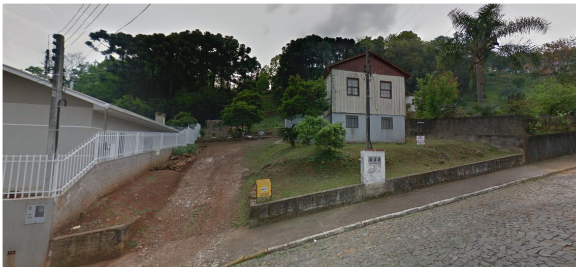
Figura 4: Testada do terreno a ser utilizado para acesso à obra
