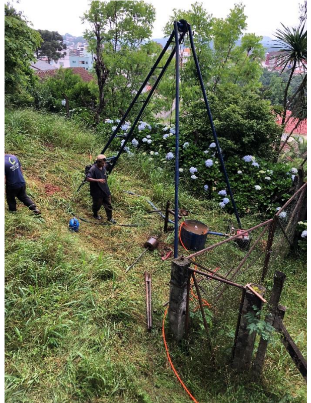
Foto 2. Momento de realização das sondagens SPT. Novembro, 2021.
