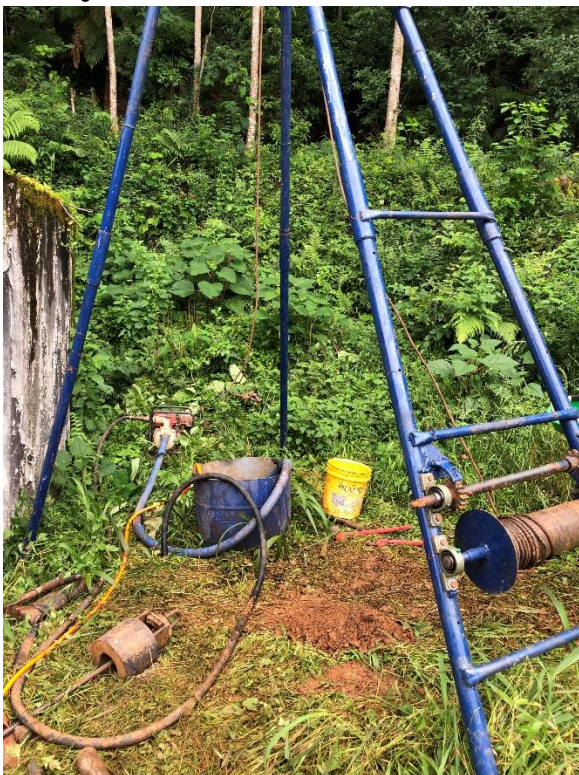
Foto 3. Momento de realização das sondagens SPT. Novembro, 2021.
