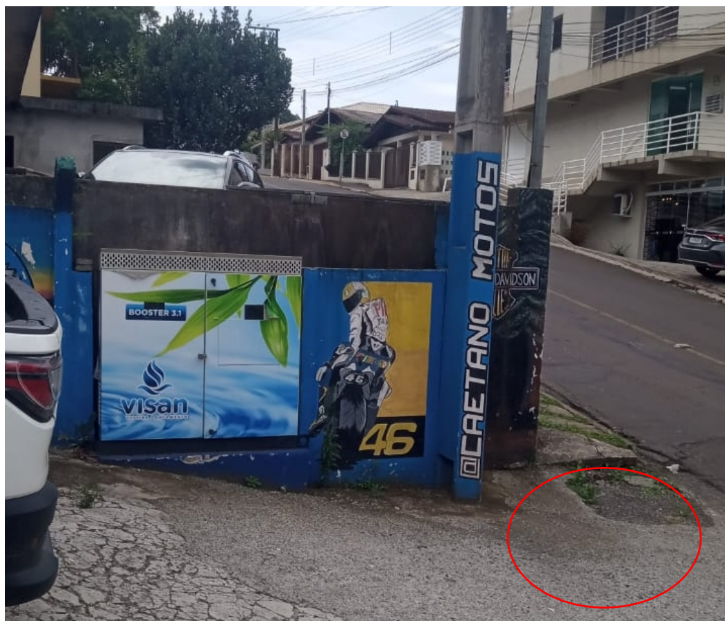
Foto 09: Local de instalação do macromedidor recalque ERAT 3.1.
