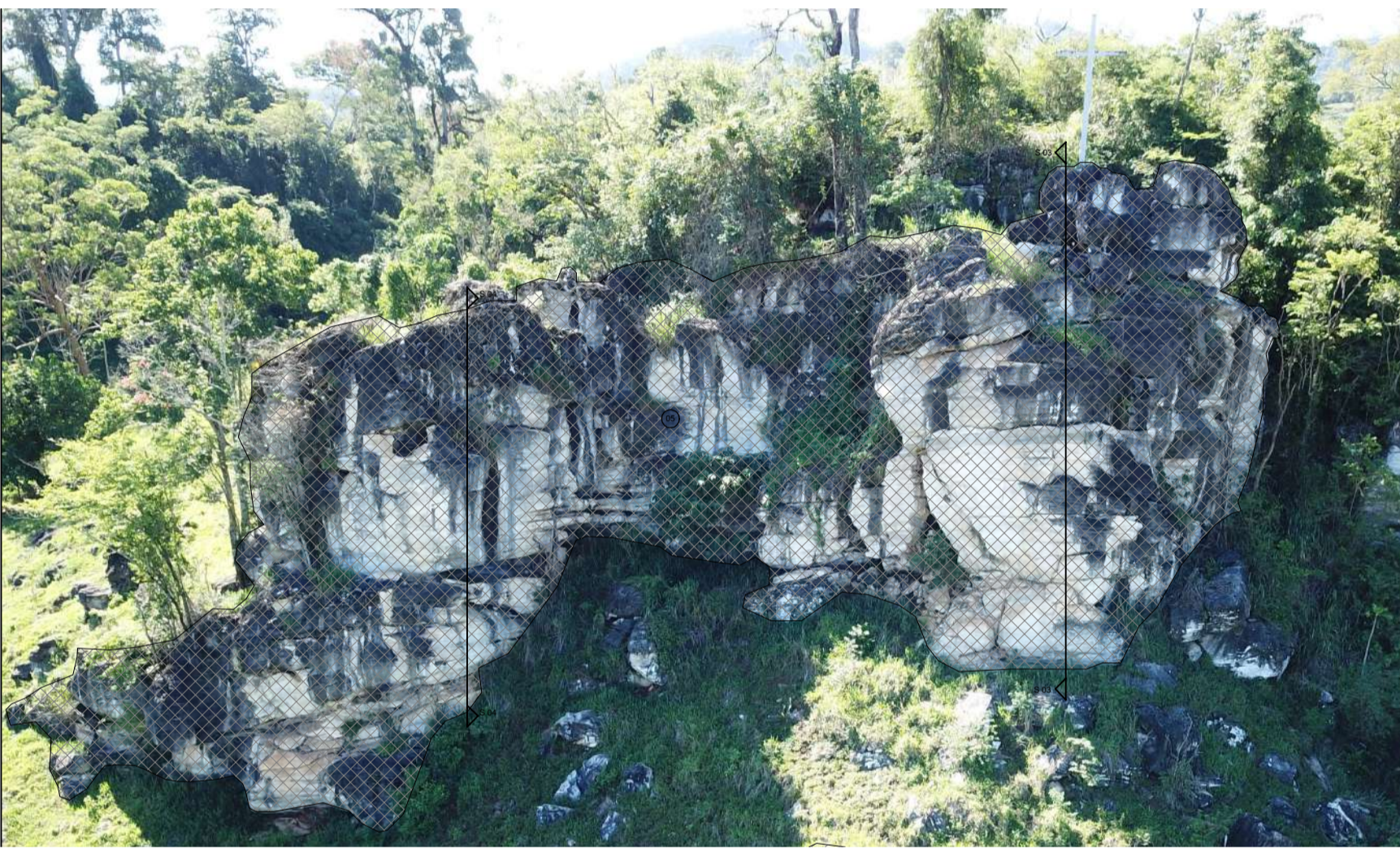
VISTA FRONTAL DA ROCHA A SER ESTABILIZADA 05 SEM ESCALA
