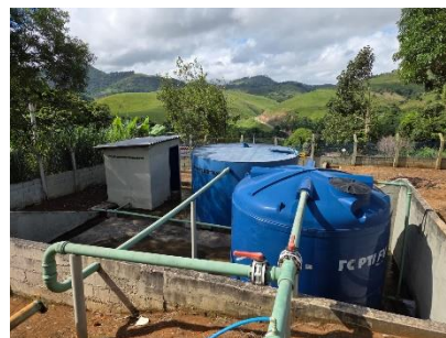
Foto 4 – Reservatórios as serem reutilizados.
