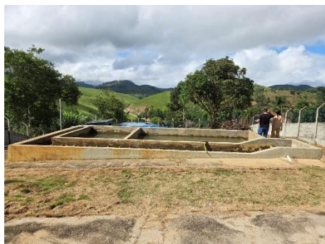
Foto 5 – Floculador/decantador a serem retirados. L=4,48m/C=8,48m/Am=1,24m
