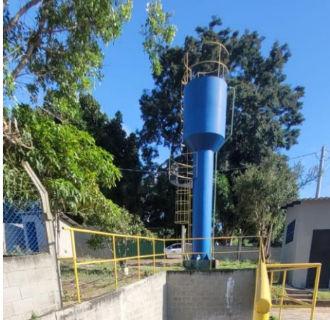
Foto 9 – Caixa d'água vertical a ser retirada. Capacidade=5.000,00 litros
