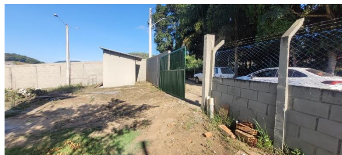
Foto 8 – Entrada da Estação de tratamento, não
