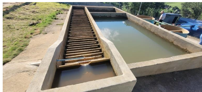
Foto 6 – Lateral do Floculador/decantador a serem retirados. L=4,48m/C=8,48m/Am=1,24m
