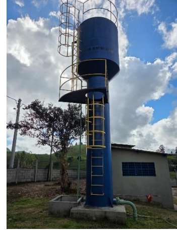
Foto 10 – Imagem lateral da Caixa d'água vertical a ser retirada.
