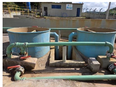
Foto 2 – Imagem frontal dos Filtros a serem retirados. D= 1,50/H=1,03
