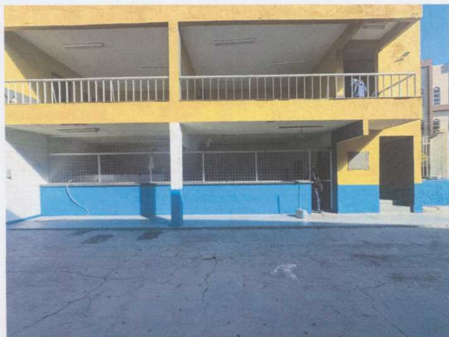
Figura 1- Vista de acesso ao imóvel avaliando
