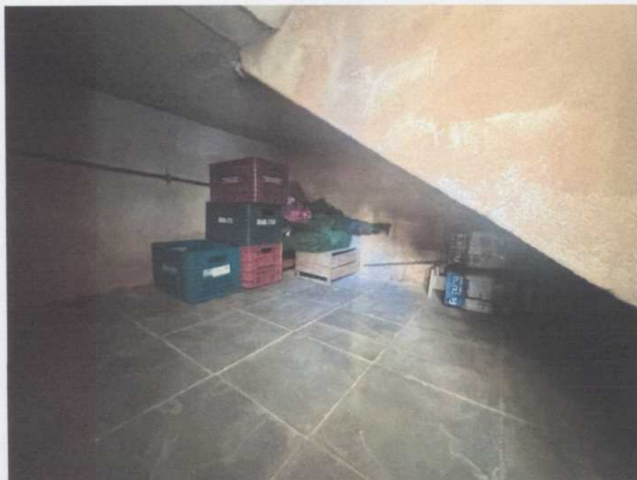
Figura 3- Vista interna do imóvel
