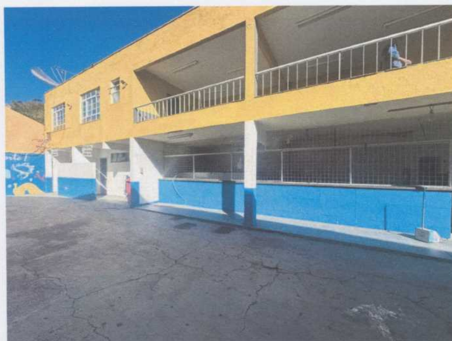
Figura 2- Vista frontal do imóvel avaliando
