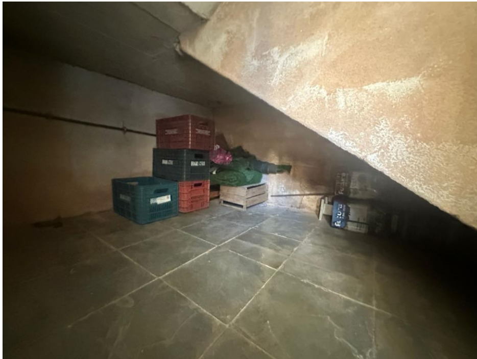
Figura 3- Vista interna do imóvel
