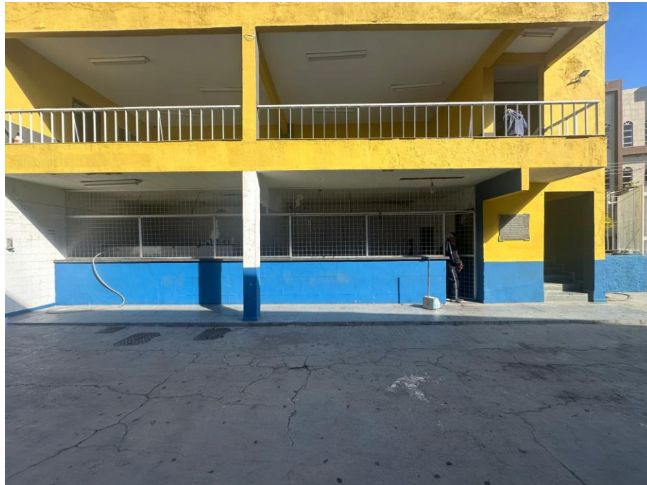
Figura 1- Vista de acesso ao imóvel avaliando
