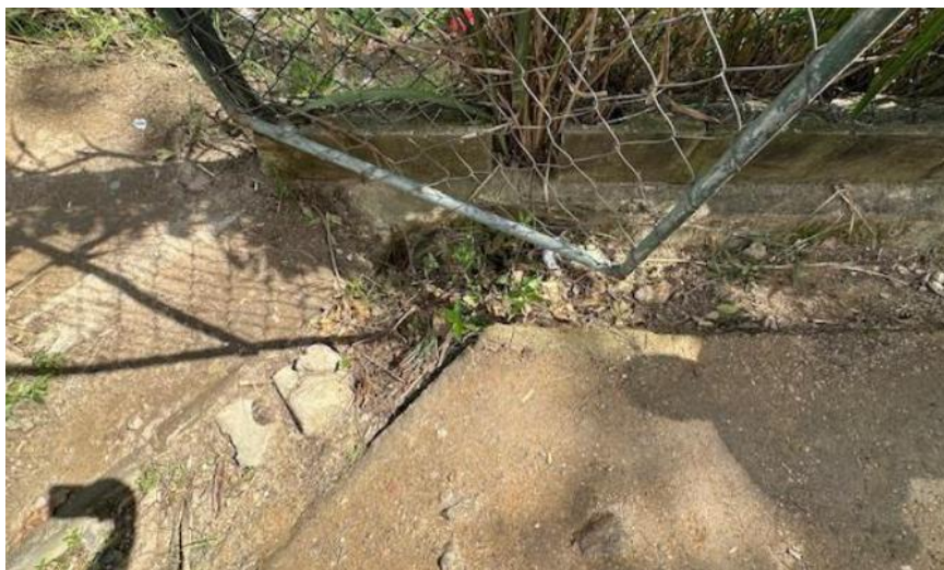
Figura 9- Canaletas obstruídas
