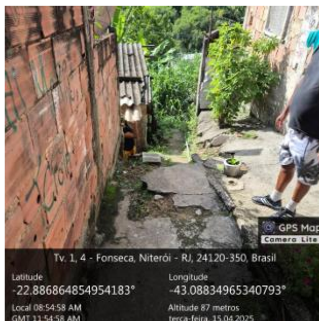
Figura 02: Foto do local de intervenção
