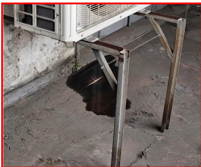
Figura 17 – Detalhe de apoio do ar condicionado
