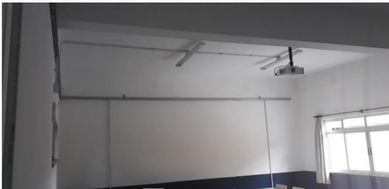
FIGURA 18 – LUMINÁRIAS TORTAS, SOLTAS OU DE MODELOS DIFERENTES
