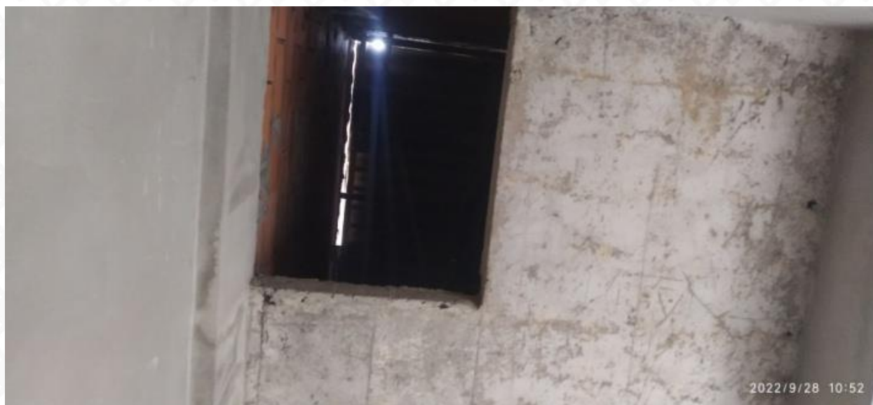
FIGURA 7 – FALTA DE ALÇAPÃO E PORTA DE ACESSO AO TELHADO
