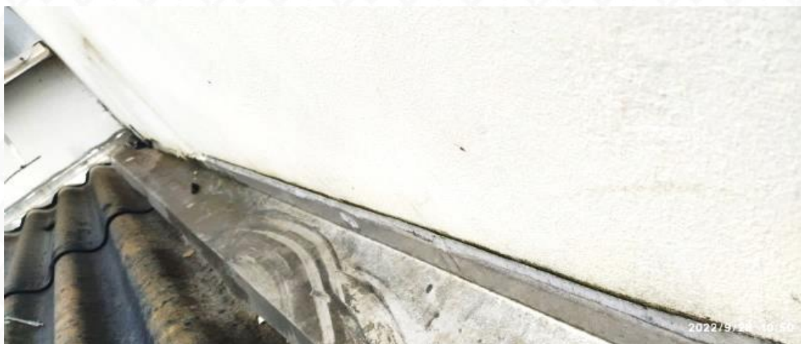
FIGURA 5 – INFILTRAÇÃO E UMIDADE ADVINDAS DA COBERTURA
