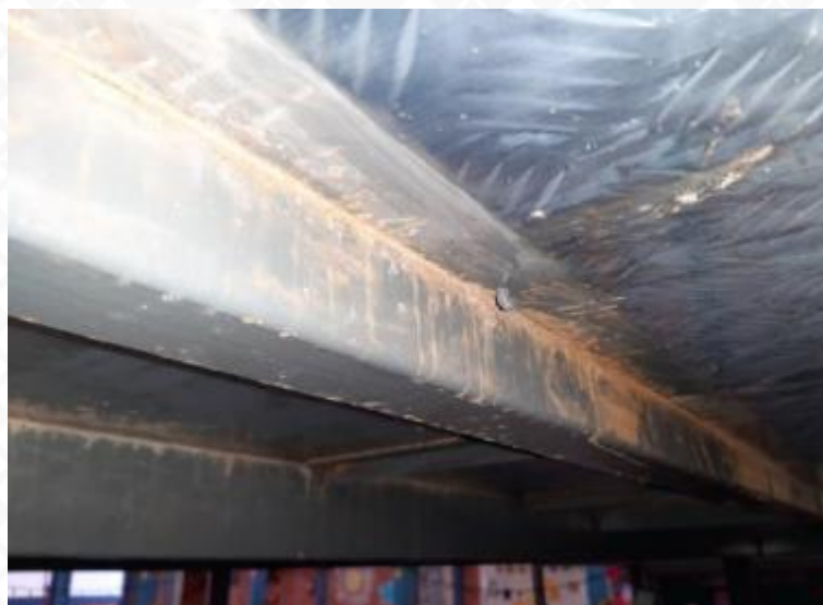
FIGURA 42 – ESCADAS METÁLICAS – SOLDAS SEM RESISTÊNCIA OU QUALIDADE
