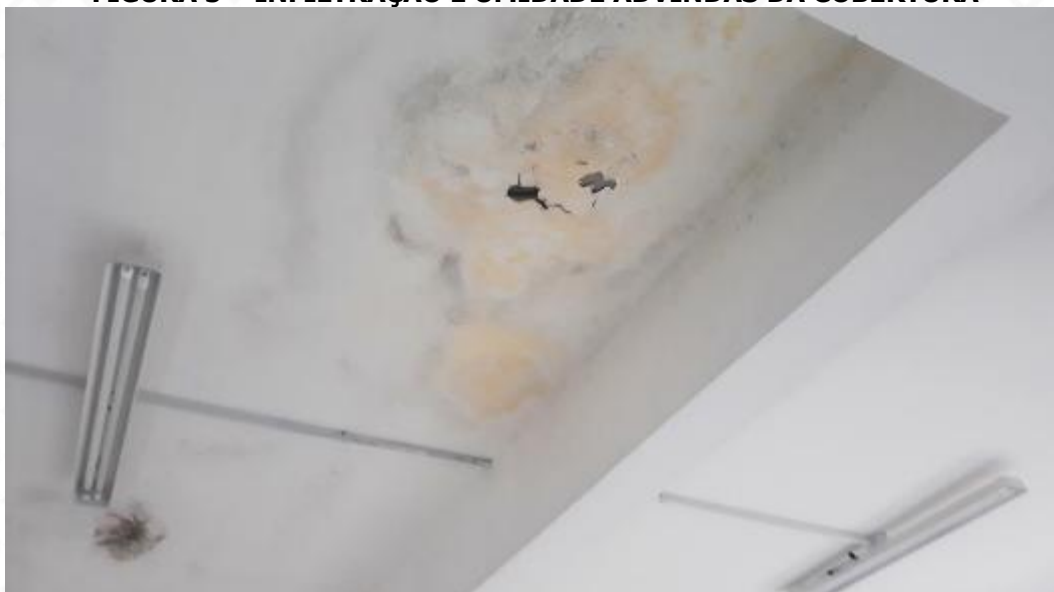
FIGURA 5 – INFILTRAÇÃO E UMIDADE ADVINDAS DA COBERTURA
