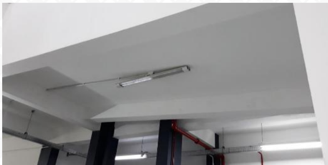
FIGURA 17 – LUMINÁRIAS TORTAS, SOLTAS OU DE MODELOS DIFERENTES
