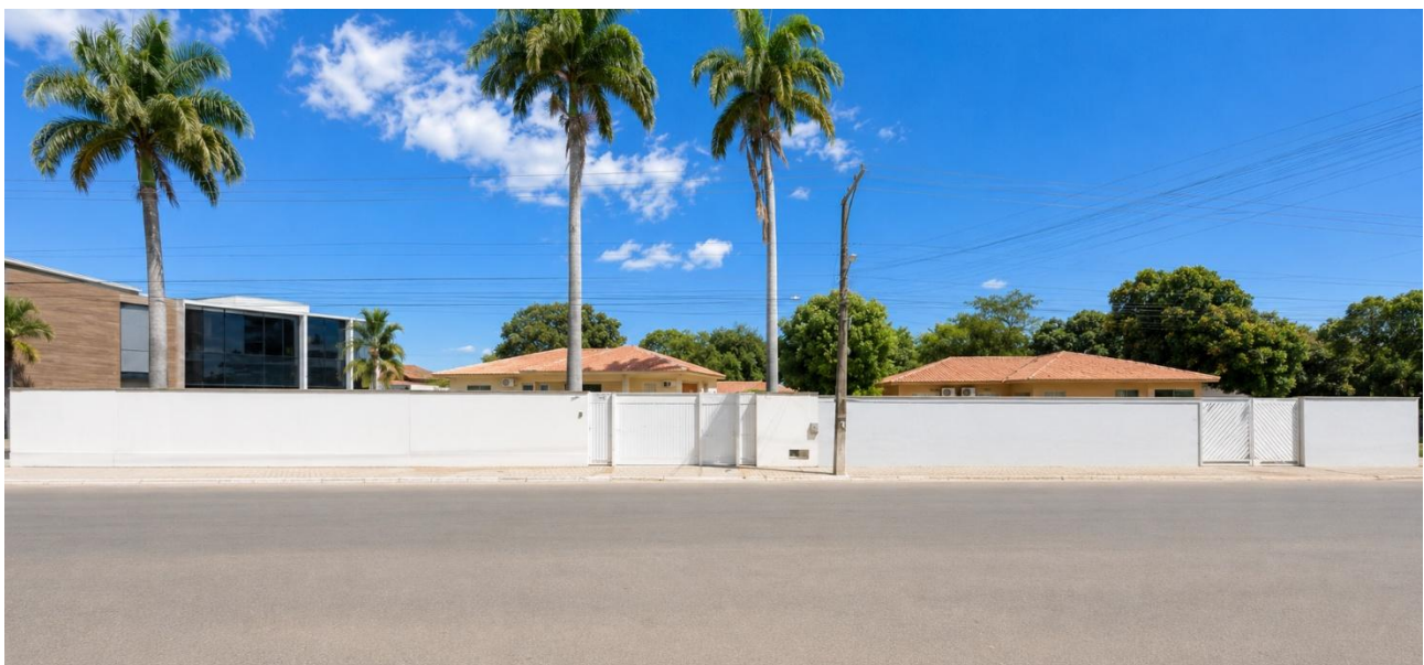
Figura 2: Vista Frontal dos imóveis
