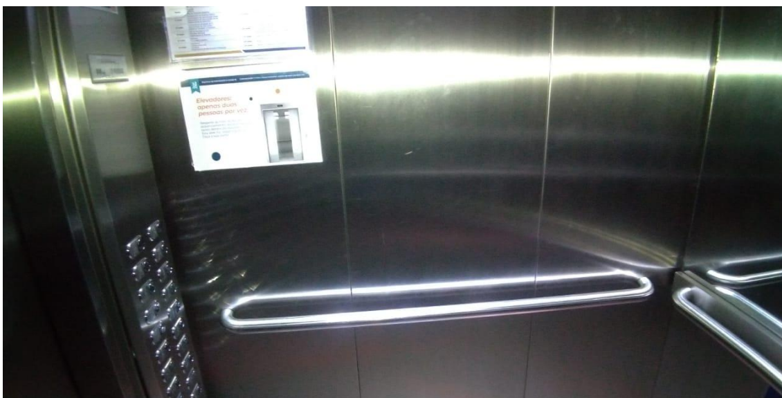
Foto 02 – Interior da cabine do elevador social
