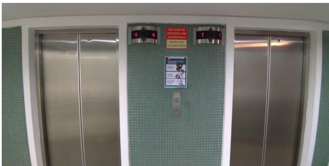
Foto 01 – Vista das portas dos elevadores sociais
