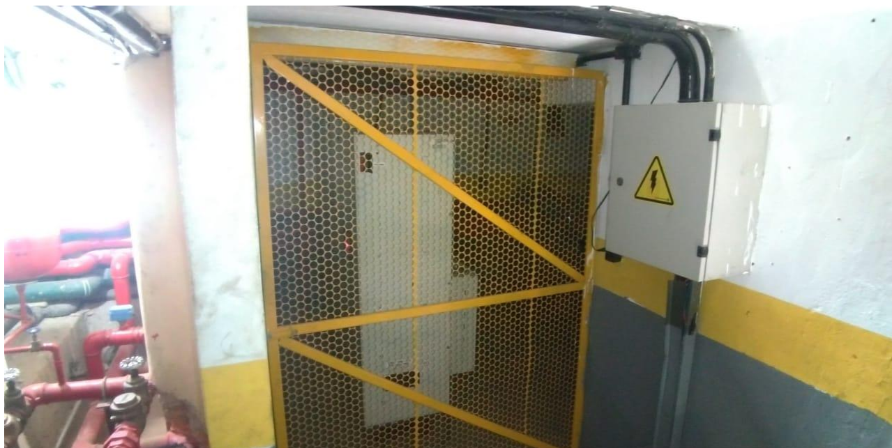
Foto 24 – Acesso à casa de máquinas, elevador de serviço
