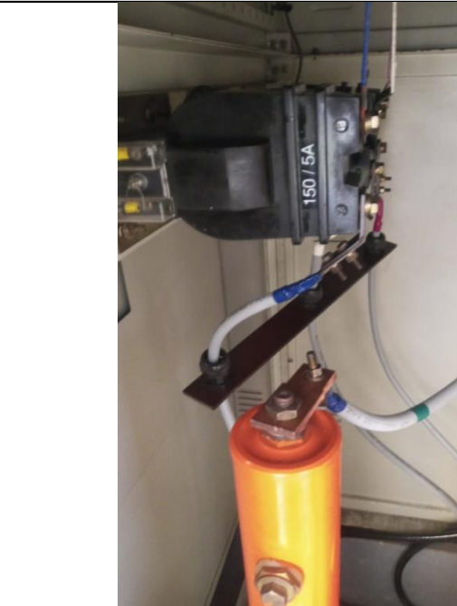
FOTO Nº 07: DETALHE DA INSTALAÇÃO DO DISJUNTOR PROVISÓRIO DE MÉDIA TENSÃO
