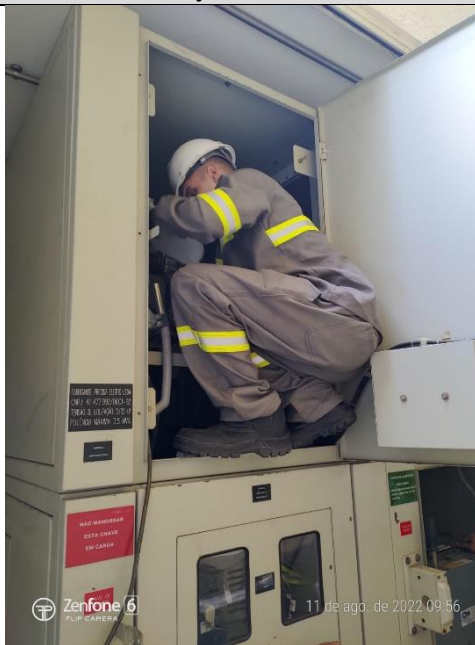
FOTO Nº 02: MANUTENÇÃO DA CHAVE SECCIONADORA
