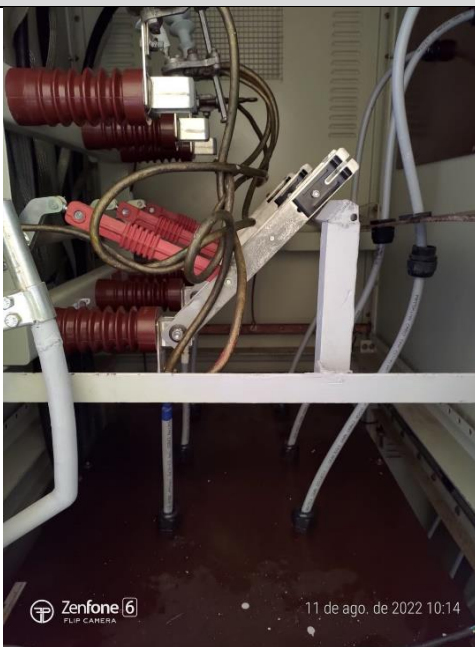
FOTO Nº 04: PÓS MANUTENÇÃO DA CHAVE SECCIONADORA
