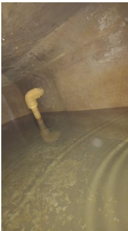
Foto 6 – Tubulação enterrada em PVC
