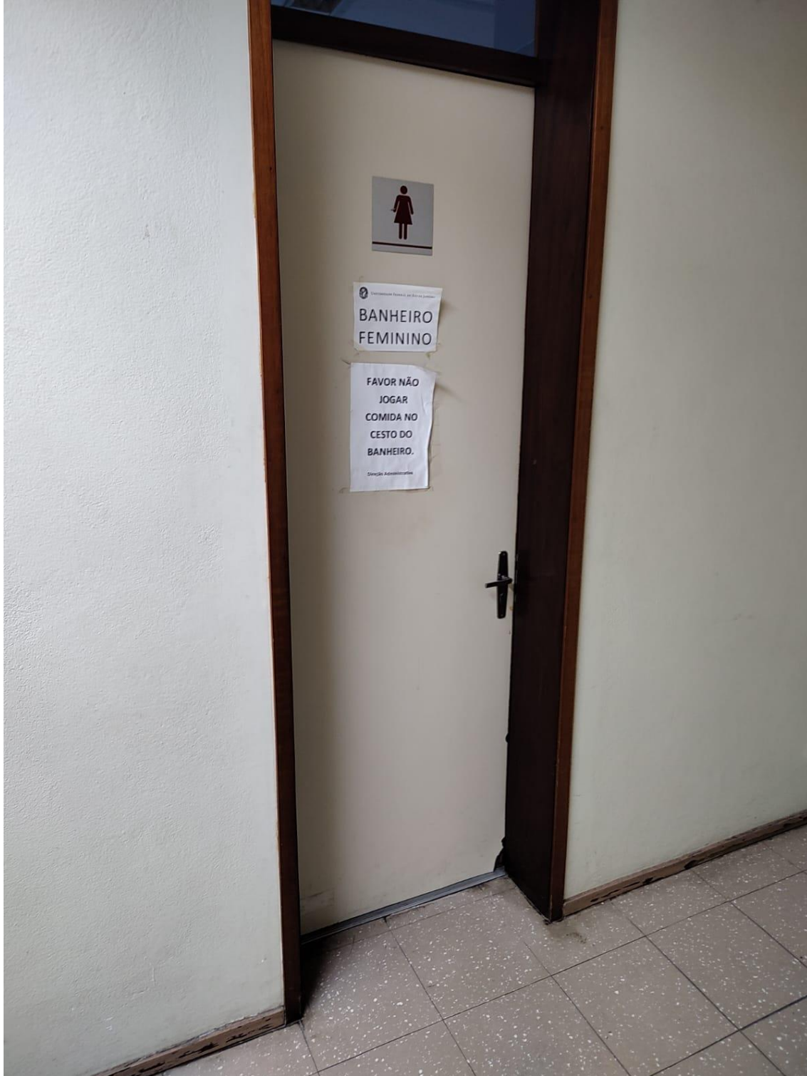
Foto 2 - Porta entrada WC feminino – Setor ASI.
