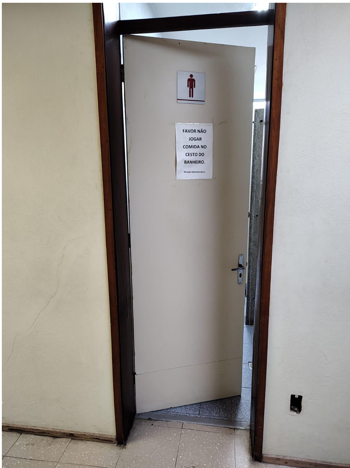
Foto 3 - Porta da entrada WC Masculino – Setor ASI
