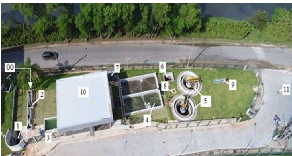
Foto 03: Tomada aérea da ETE-CTV
