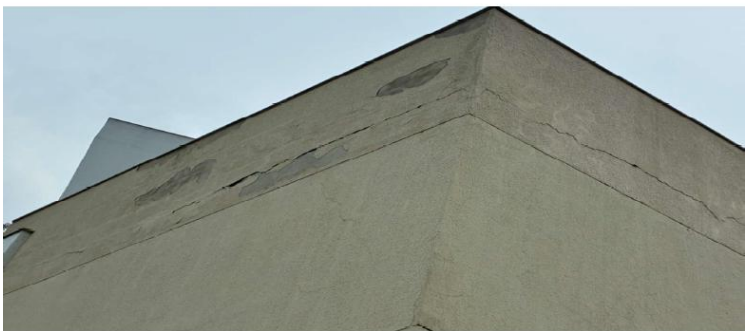
Imagens 02 e 03: Fachada lateral inferior e superior do prédio sede.
