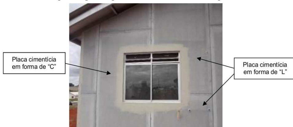
Figura 3 – Paginação das placas cimentícias em aberturas
