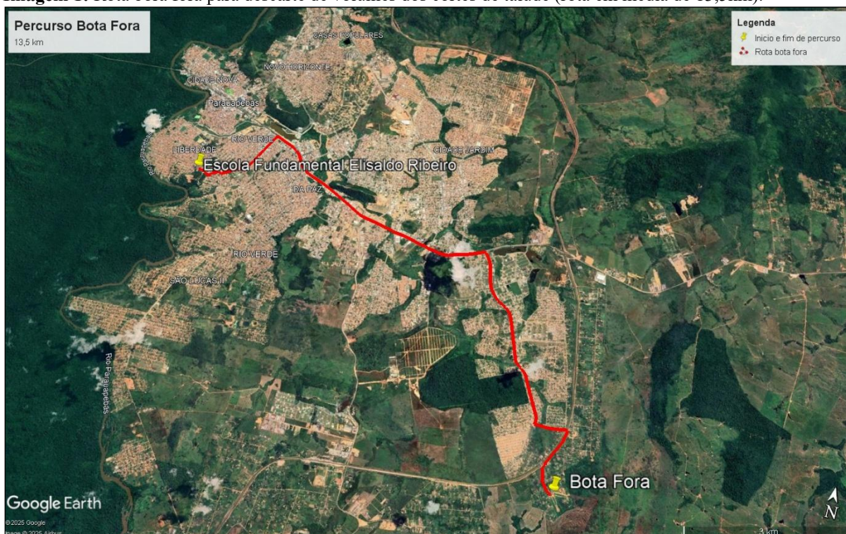
Imagem 1: Rota bora fora para descarte de volumes dos cortes de talude (rota em média de 13,5km).
