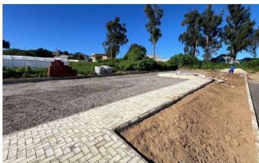
Figura 65 - Estacionamento em execução
