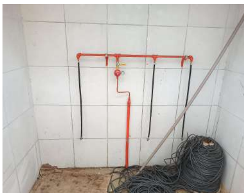
Figura 55 - Casa de gás
