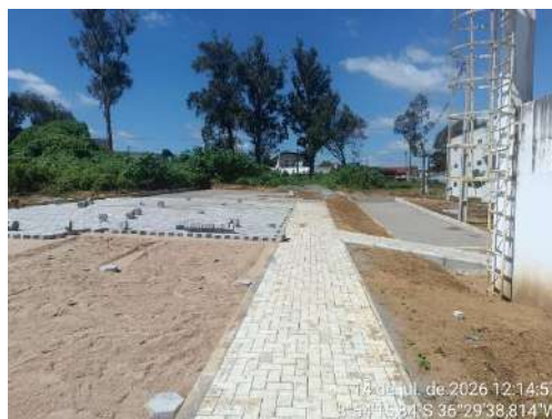
Figura 66 - Via de acesso/ Carga e descarga em execução
