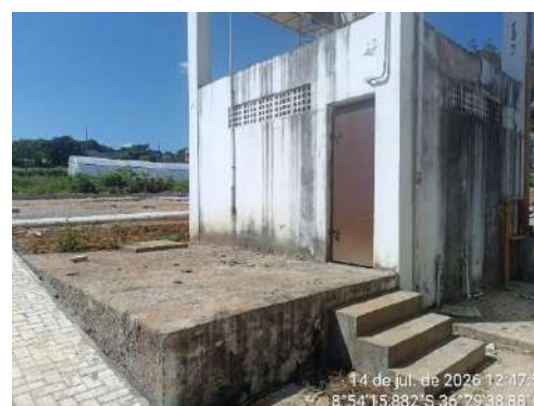
Figura 60 - Acesso a casa de bombas
