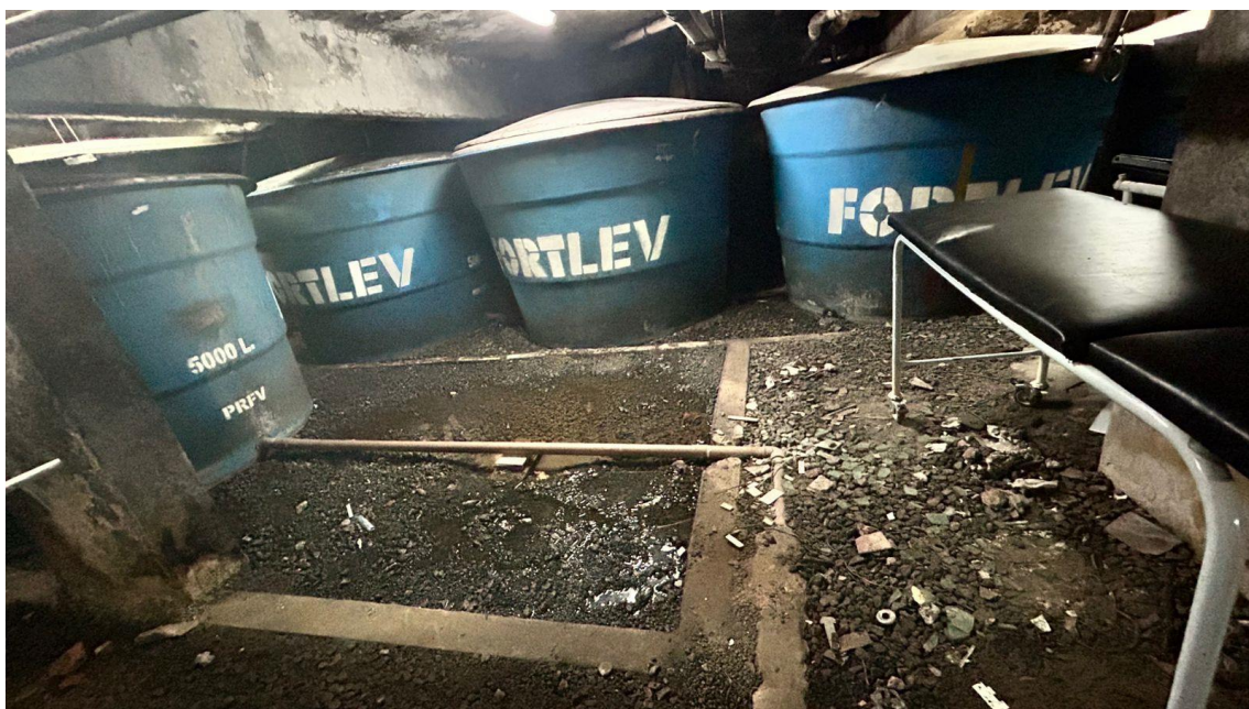
Imagem 6 - Base de brita onde as caixas de água estão alocadas atualmente
