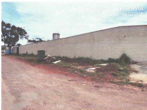
IMAGEM 03 – CALÇADA DO FUNDO A SER EXECUTADA.
