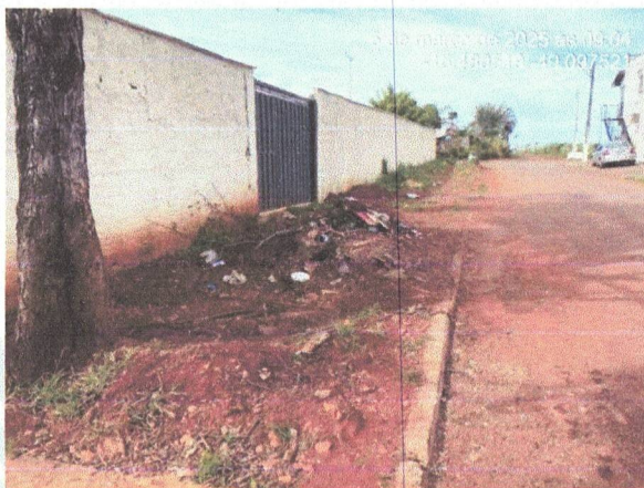
IMAGEM 04 – CALÇADA DO FUNDO A SER EXECUTADA.
