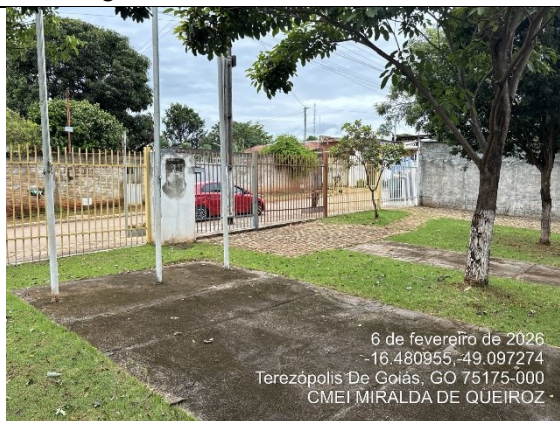
Imagem 03 – Gradil de fechamento.
