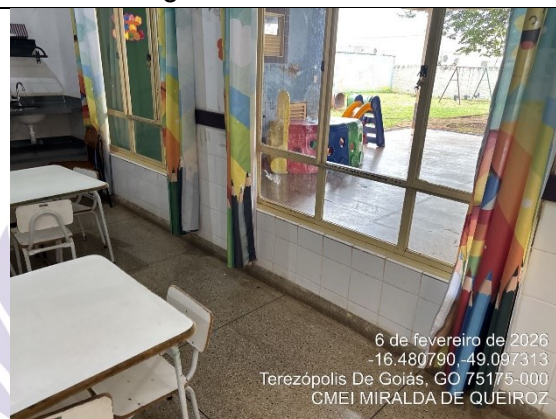
Imagem 32 – Janelas das salas de aula.
