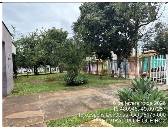
Imagem 02 – Gradil de fechamento.
