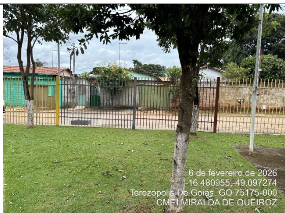
Imagem 01 – Gradil de fechamento.
