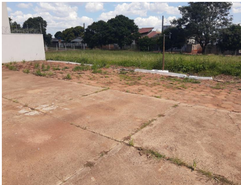
(Piso a receber pintura)
