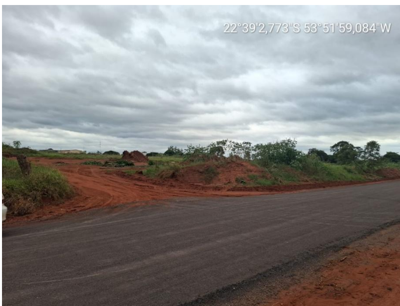
Acesso à obra - Fonte: Autor
