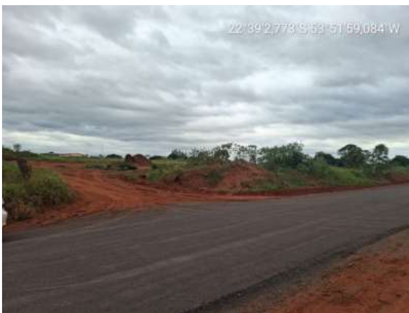
Acesso à obra - Fonte: Autor
