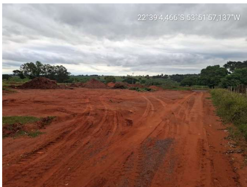
Local da obra – Fonte: Autor
