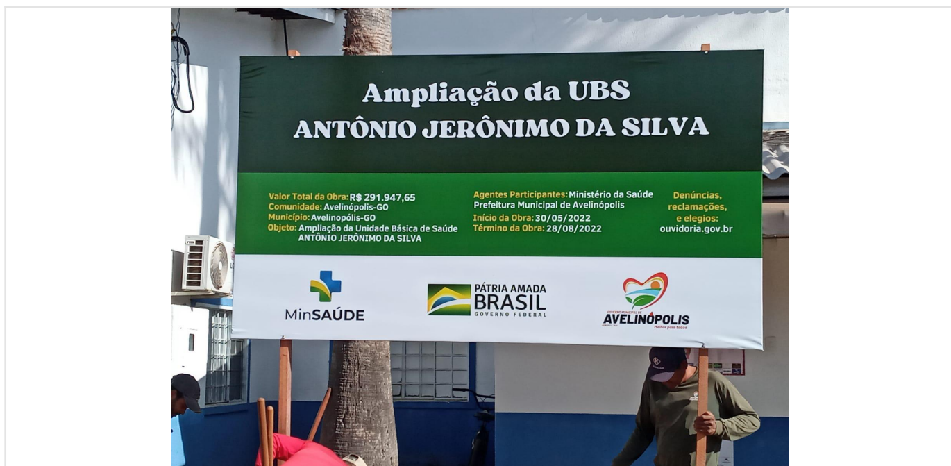
Placa da obra Data da última atualização: 04/04/2024
