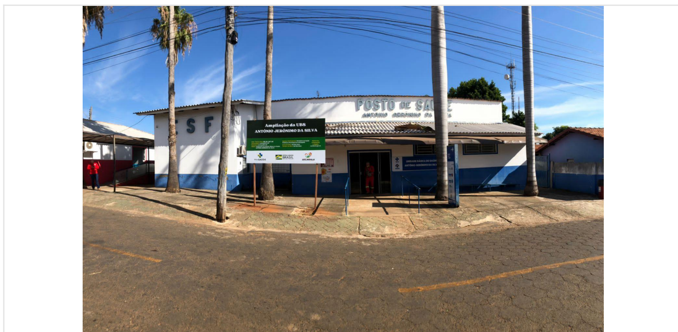
Placa da obra Data da última atualização: 04/04/2024
