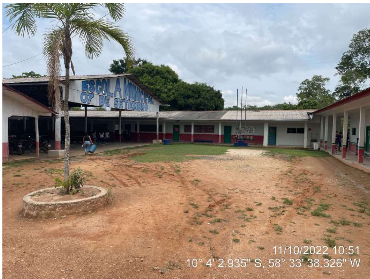
Local a construir novo Pátio Coberto.
