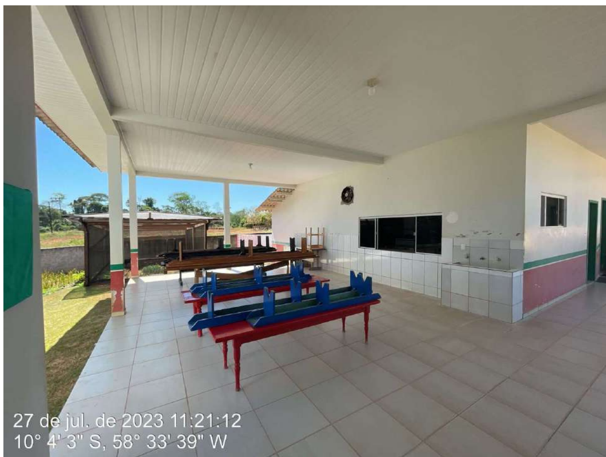
Refeitório a ser ampliado.
