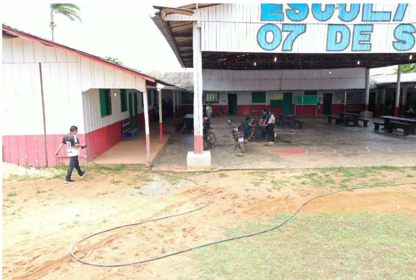
Bloco ADM Existente em Madeira – Demolir
