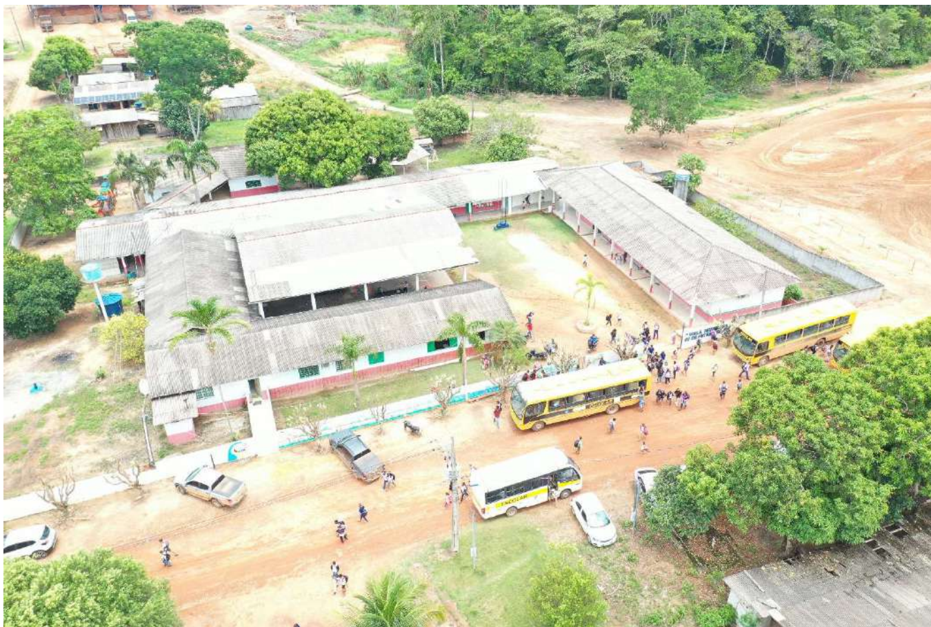
Vista aérea entrada
