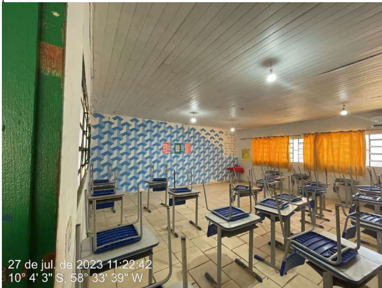
Sala bloco frente – a reformar com troca de piso, forro, cobertura, instalações e nova pintura.
