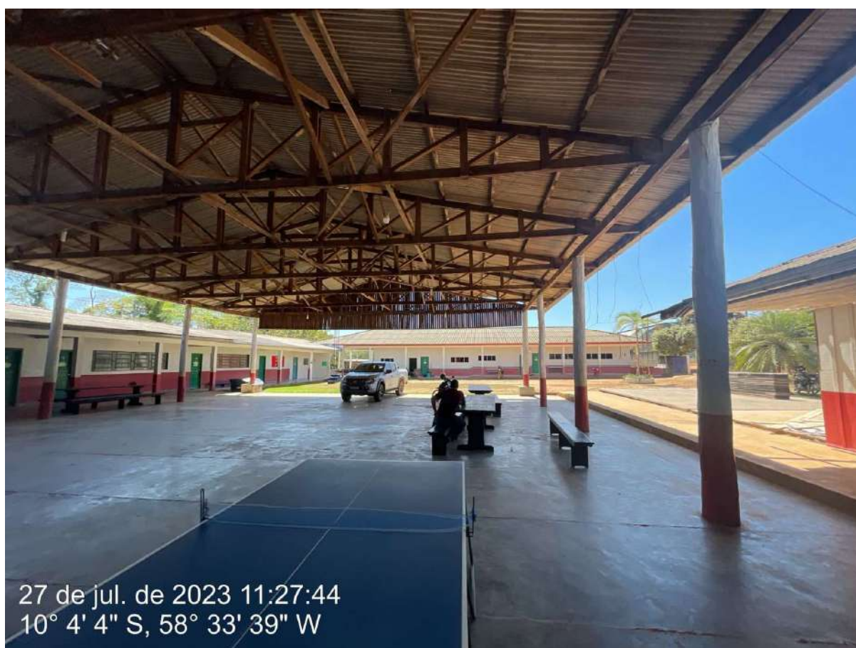
Pátio coberto a demolir
