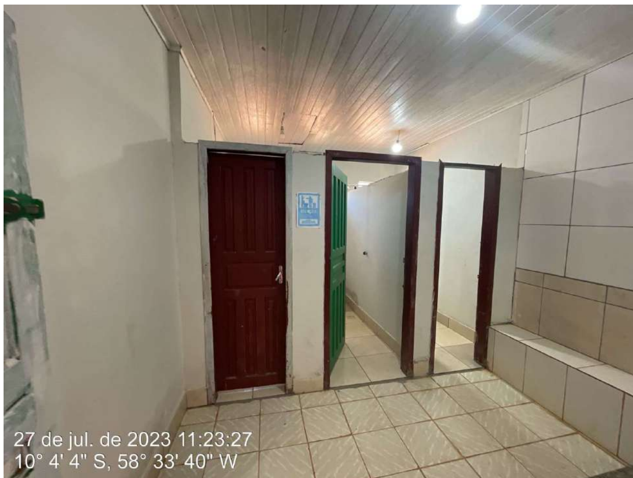
Banheiros a serem demolidos para construção de novos.
