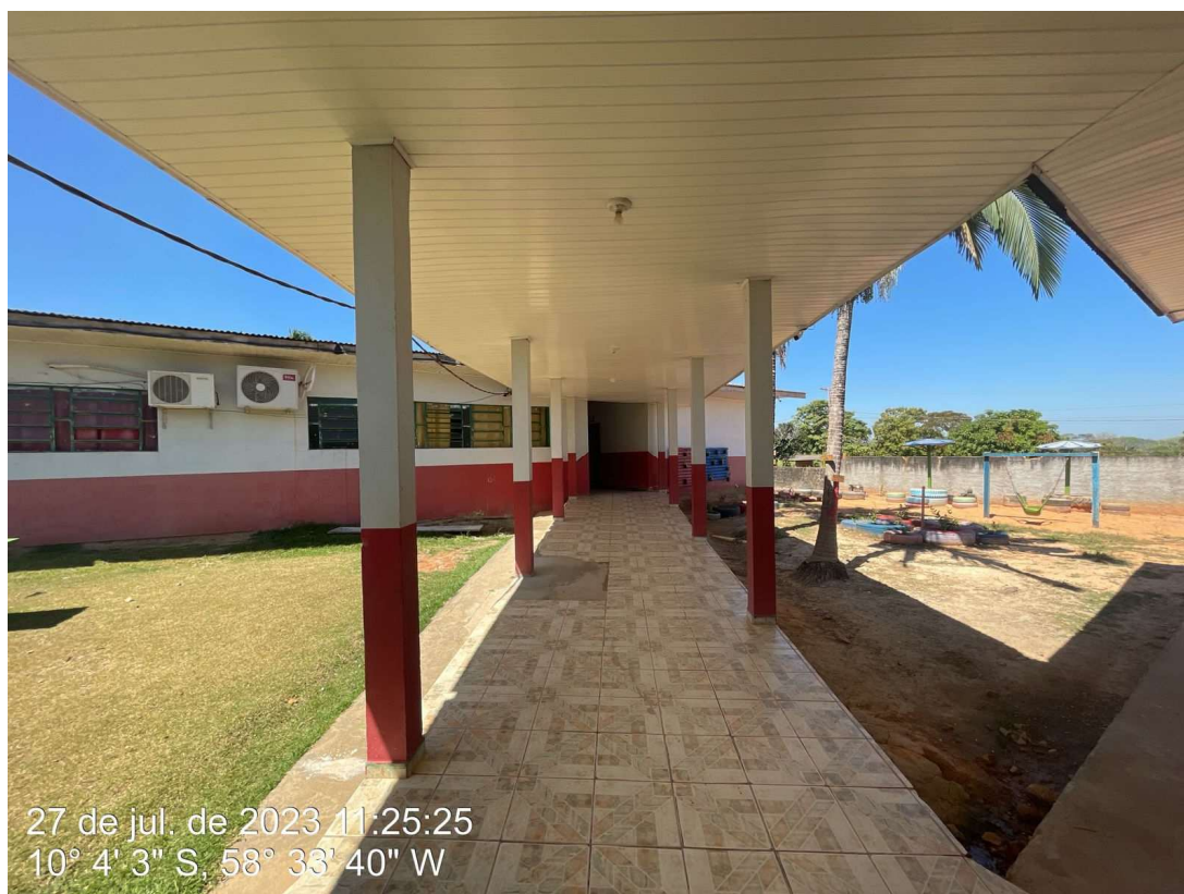
Circulação de acesso ao bloco do fundo, reformar com troca de piso, forro, cobertura e nova pintura.
