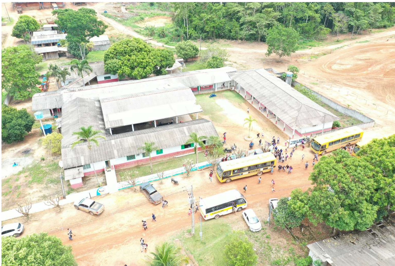
Vista aérea entrada
