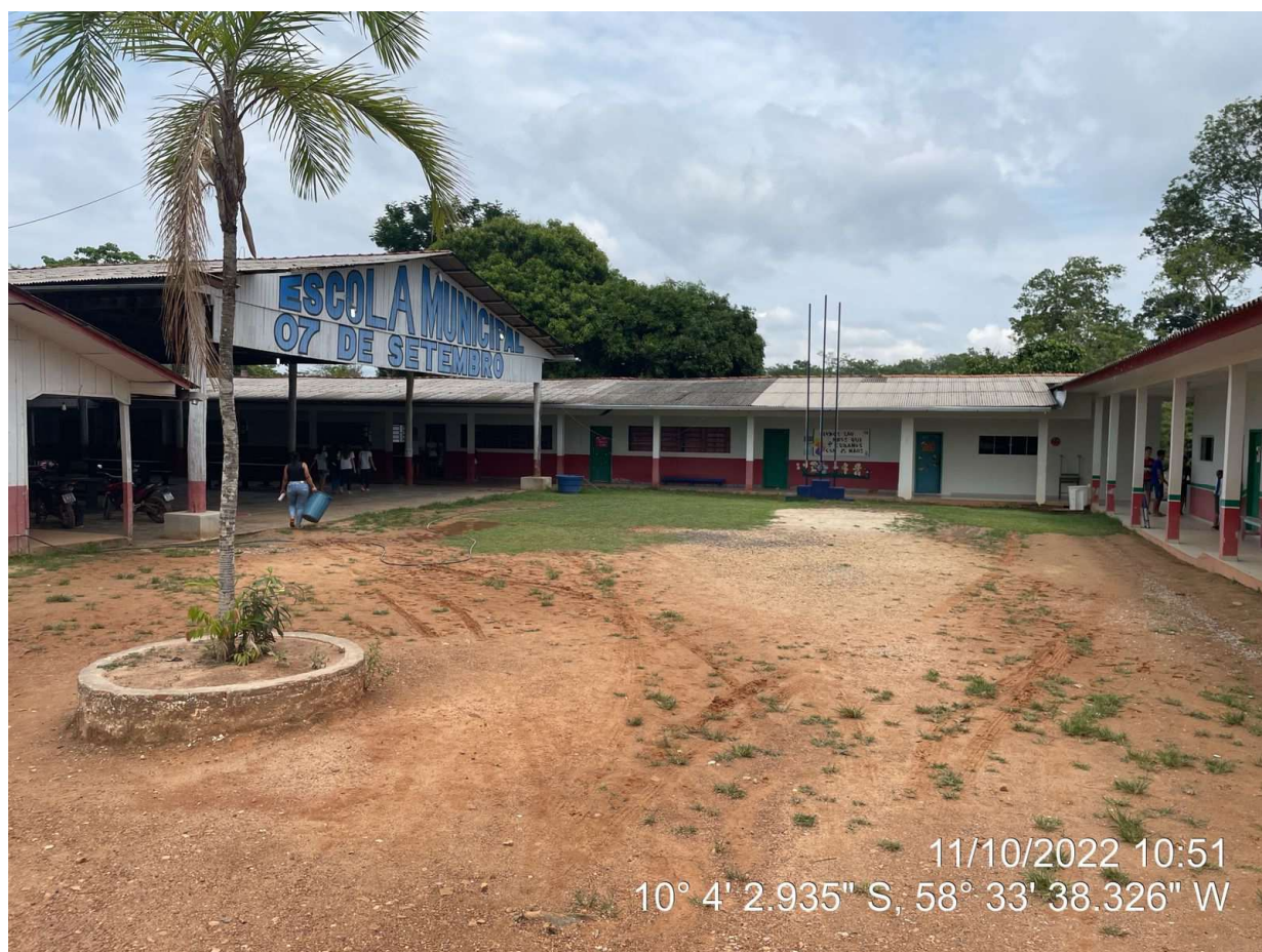
Local a construir novo Pátio Coberto.
