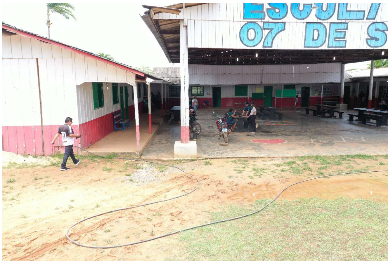
Bloco ADM Existente em Madeira – Demolir
