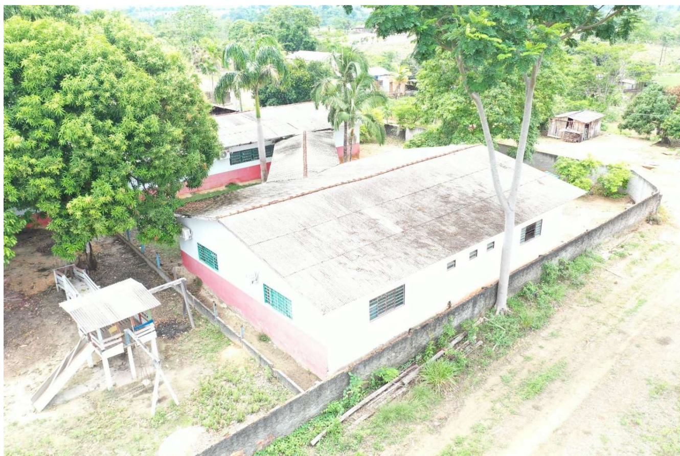
Bloco Salas Fundo existente em Alvenaria – Reformar com troca de pisos, troca de telhado, troca de forro, instalações, adequação de rampas e nova pintura.
