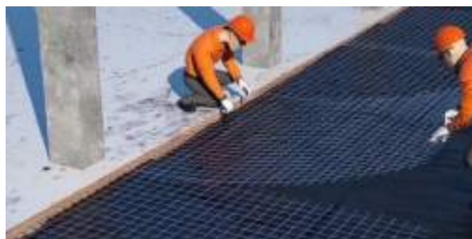
Figura 56 - Instalação de Tela em Pavimento de Concreto
