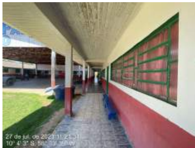
Figura 12 - EMEB 7 de Setembro – Circulação com janelas de Ferro.
