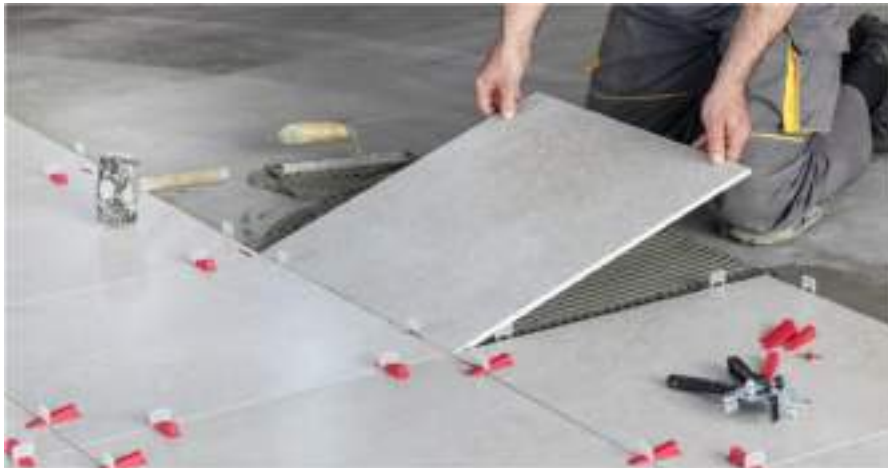
Figura 22 – Assentamento de revestimento cerâmico para piso.
