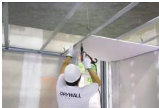
Figura 26 – Fixação de placas de gesso acartonado
