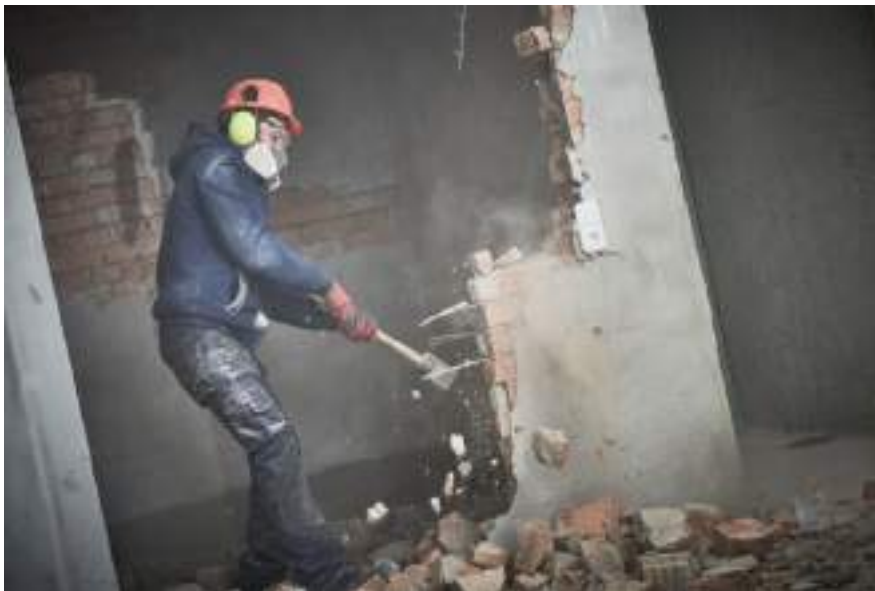
Figura 9 – Demolição de alvenaria
