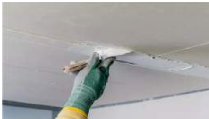
Figura 27 – Aplicação de massa nas juntas da placa de gesso acartonado.
