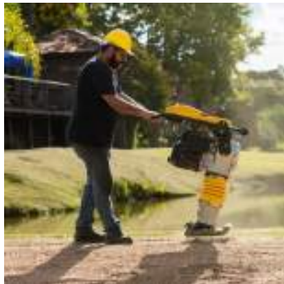
Figura 54 - Uso de Compactador de Solos de Percussão (soquete)
