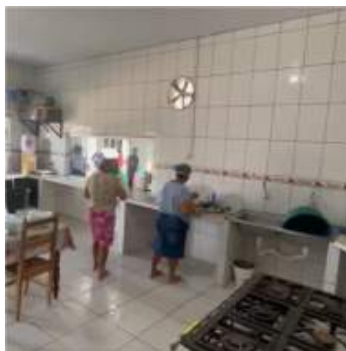
Figura 8 - EMEB 7 de Setembro – Cozinha com bancada de concreto armado.
