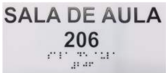
Figura 53 - Placa de Identificação de ambiente com braile.
