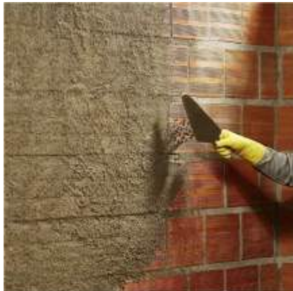
Figura 18 – Execução de Chapisco com colher de pedreiro
