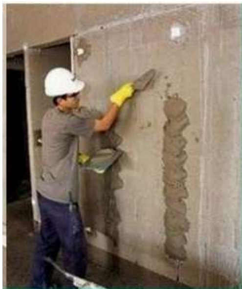
Figura 19 – Execução de talisca e mestra do reboco
