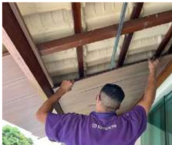
Figura 28 - Instalação de Forro de PVC em beiral
