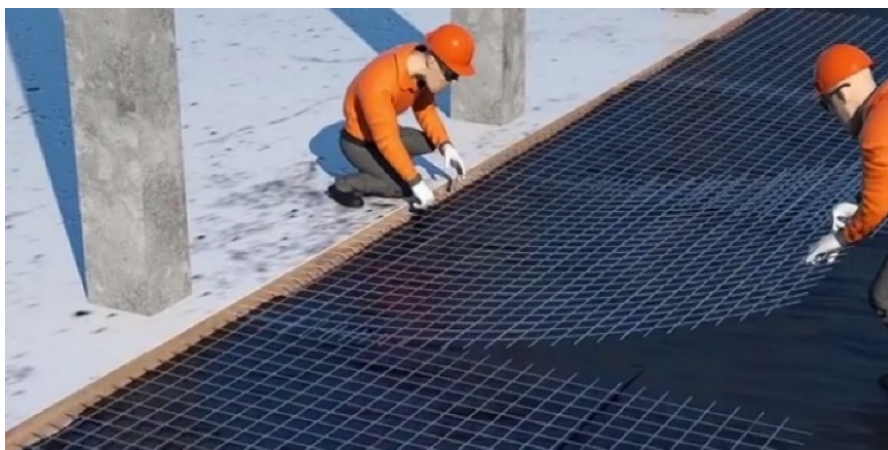
Figura 36 - Instalação de Tela em Pavimento de Concreto
