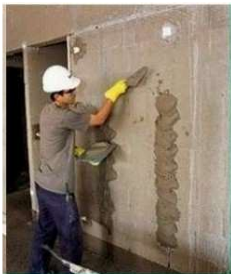
Figura 11 – Execução de talisca e mestra do reboco
