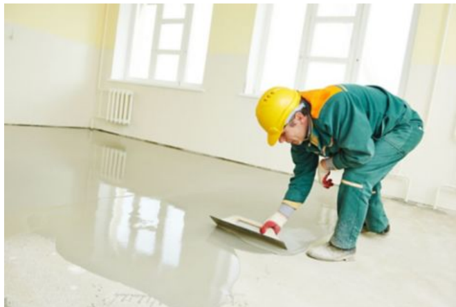
Figura 12 – Regularização de contrapiso existente com nata de cimento
