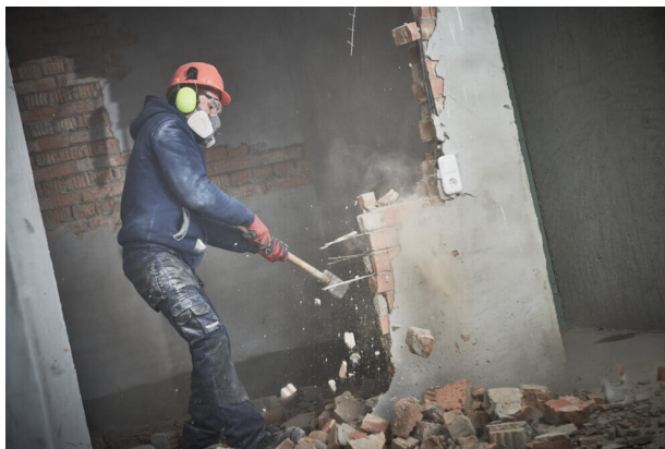
Figura 8 – Demolição de alvenaria
