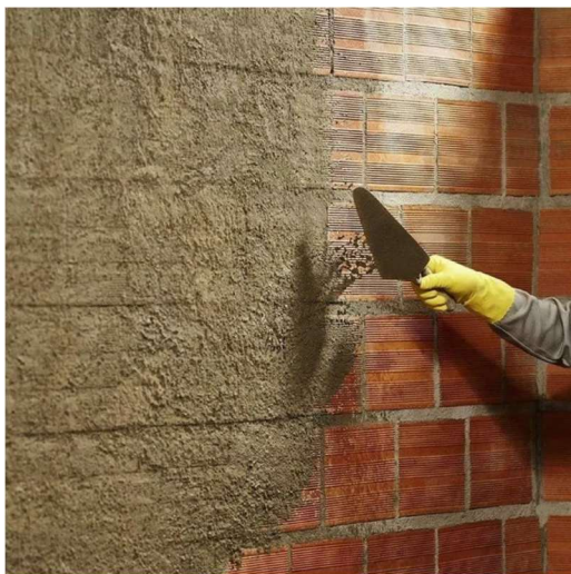
Figura 37 – Execução de Chapisco com colher de pedreiro
