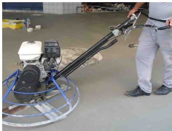
Figura 13 – Polimento de piso de concreto
