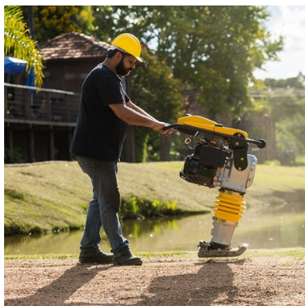
Figura 23 - Uso de Compactador de Solos de Percussão (soquete)
