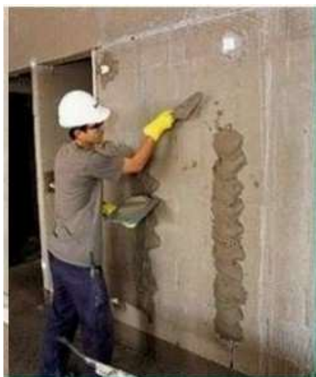
Figura 38 – Execução de talisca e mestra do reboco
