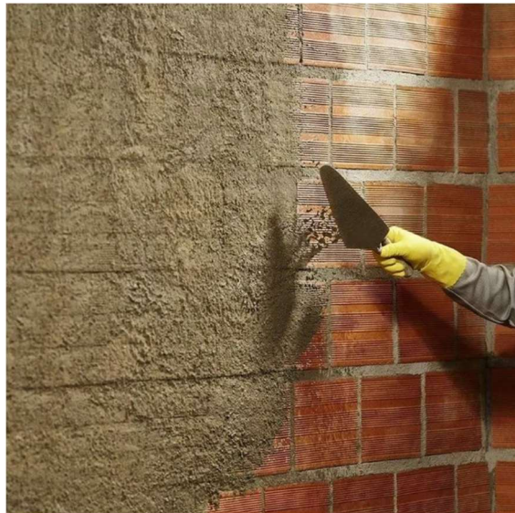
Figura 10 – Execução de Chapisco com colher de pedreiro
