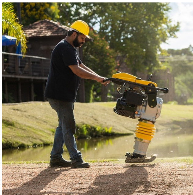
Figura 19- Uso de Compactador de Solos de Percussão (soquete)
