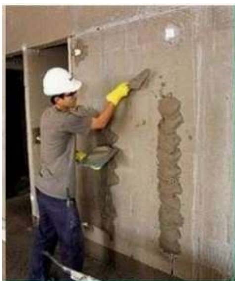
Figura 6 – Execução de talisca e mestra do reboco
