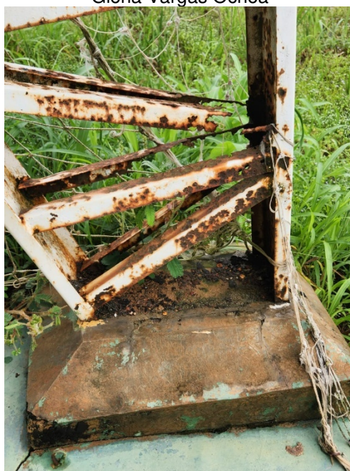
Figura 14 – Detalhe da base da estrutura metálica da cobertura da quadra da E.E. Maria da Glória Vargas Ochoa
