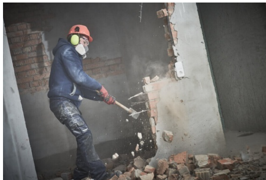
Figura 17 – Demolição de alvenaria
