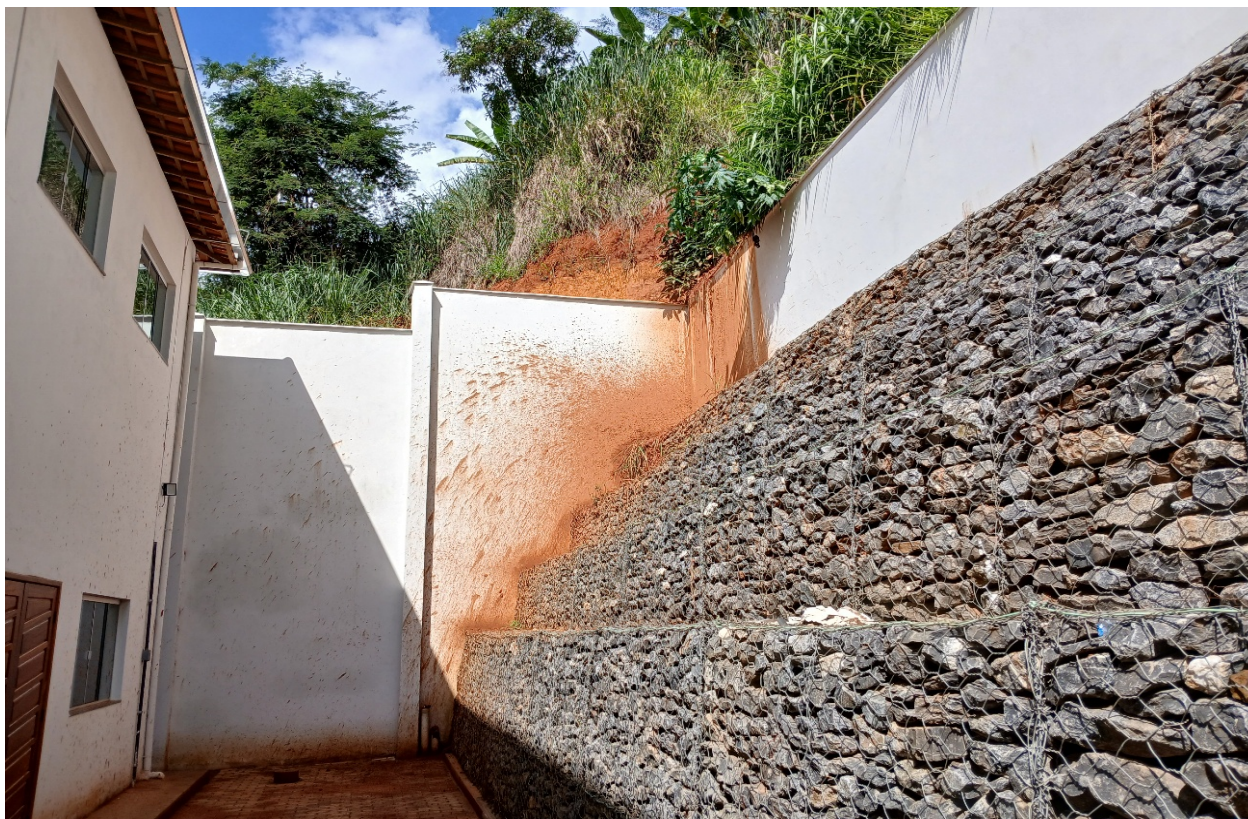
Foto 02- visão da extensão do talude e arrimo
